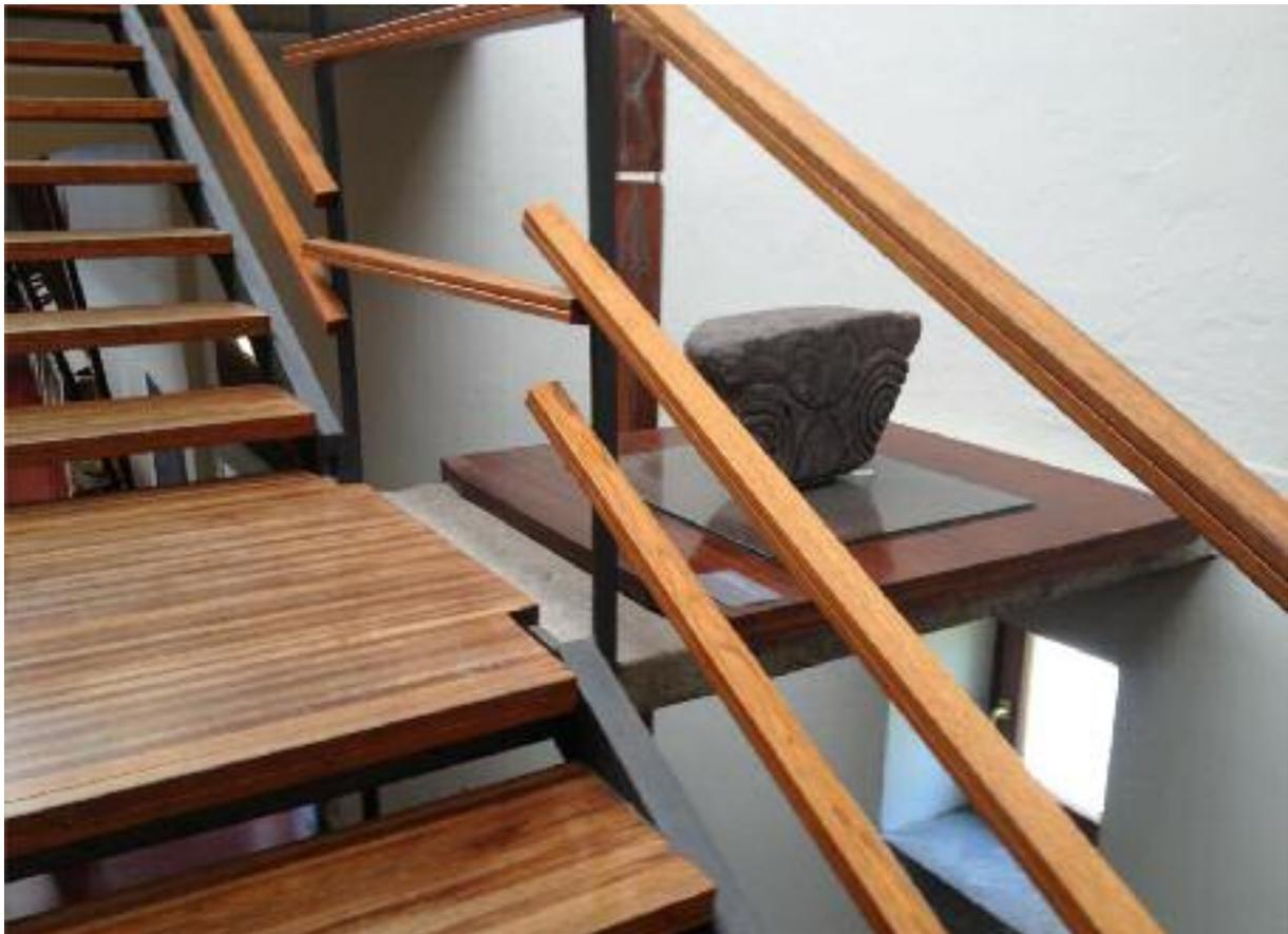
Particolare della scala in ferro con il pianerottolo in calcestruzzo bocciardato (foto di N.F.)
