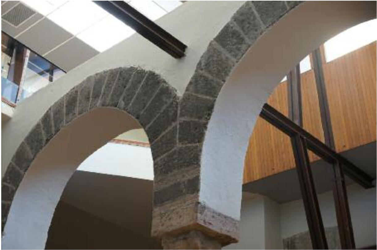
Soluzione delle nuove travi in ferro che sostengono la serie degli archi murari all'interno (foto di N.F.)
