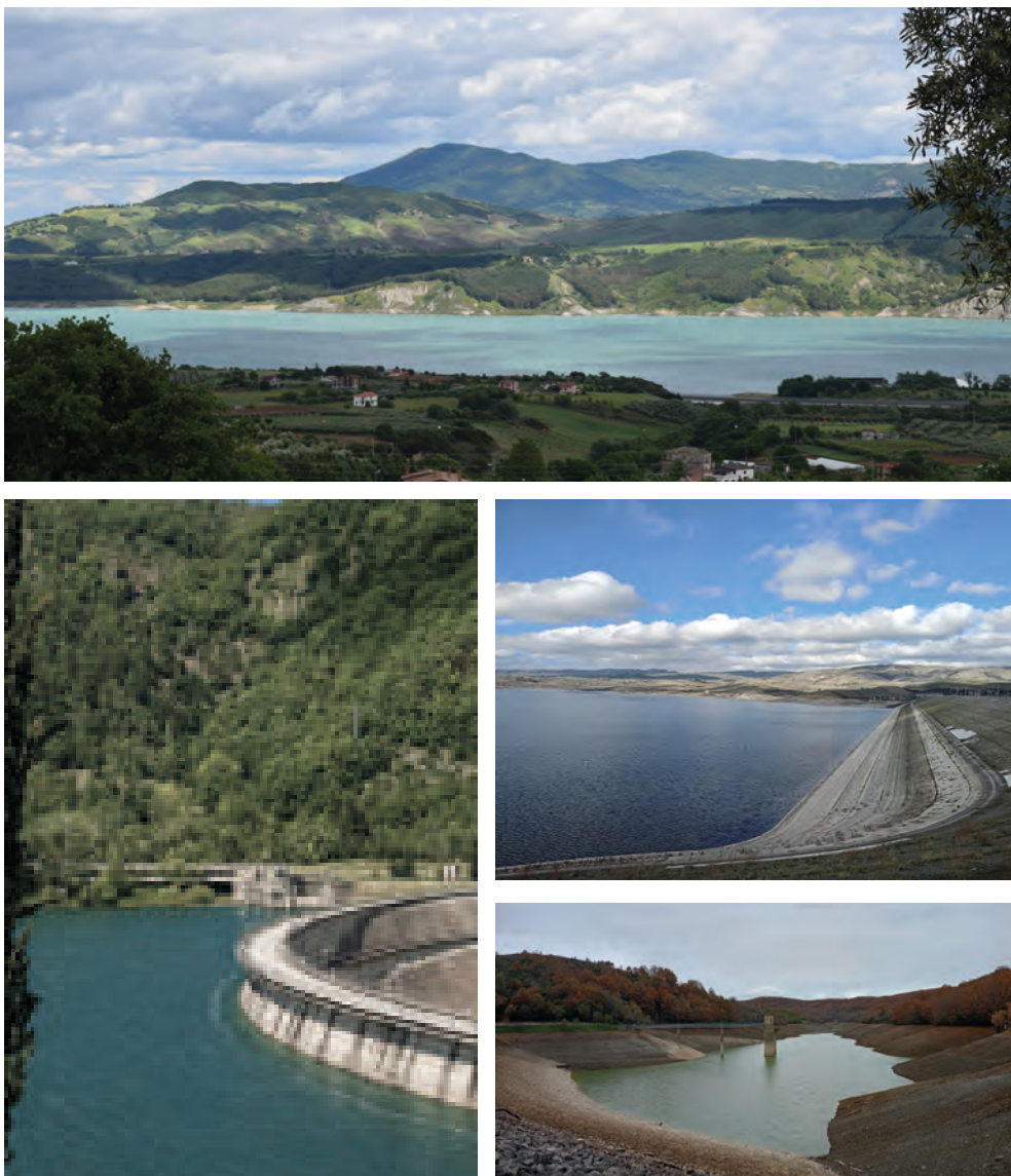
Argini di sbarramento e bacini artificiali in Campania e Basilicata. Fotografie di Di Palma B. e Verrillo M., 2021-2025.
