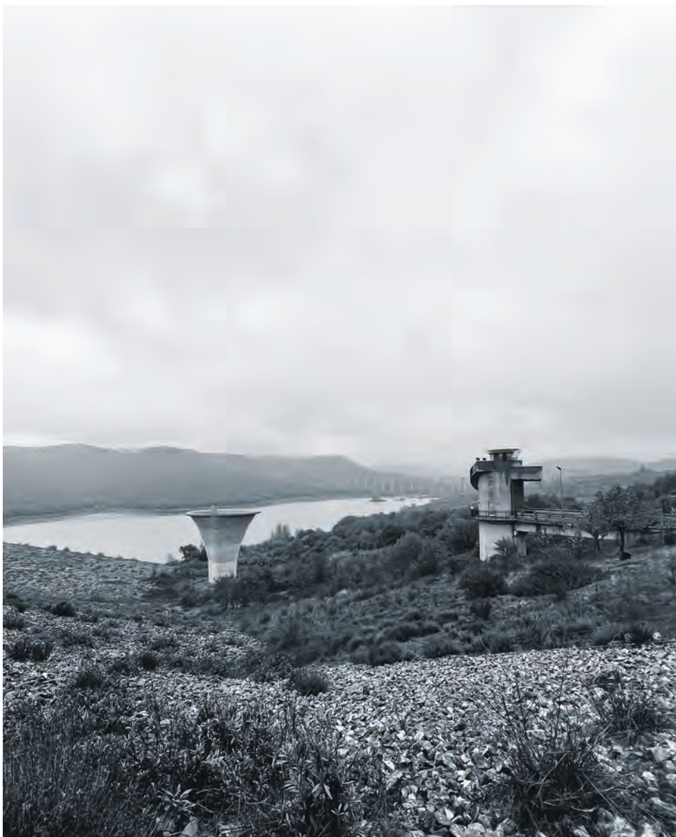
La diga di Acerenza. Fotografia di Verrillo M., 2021.
