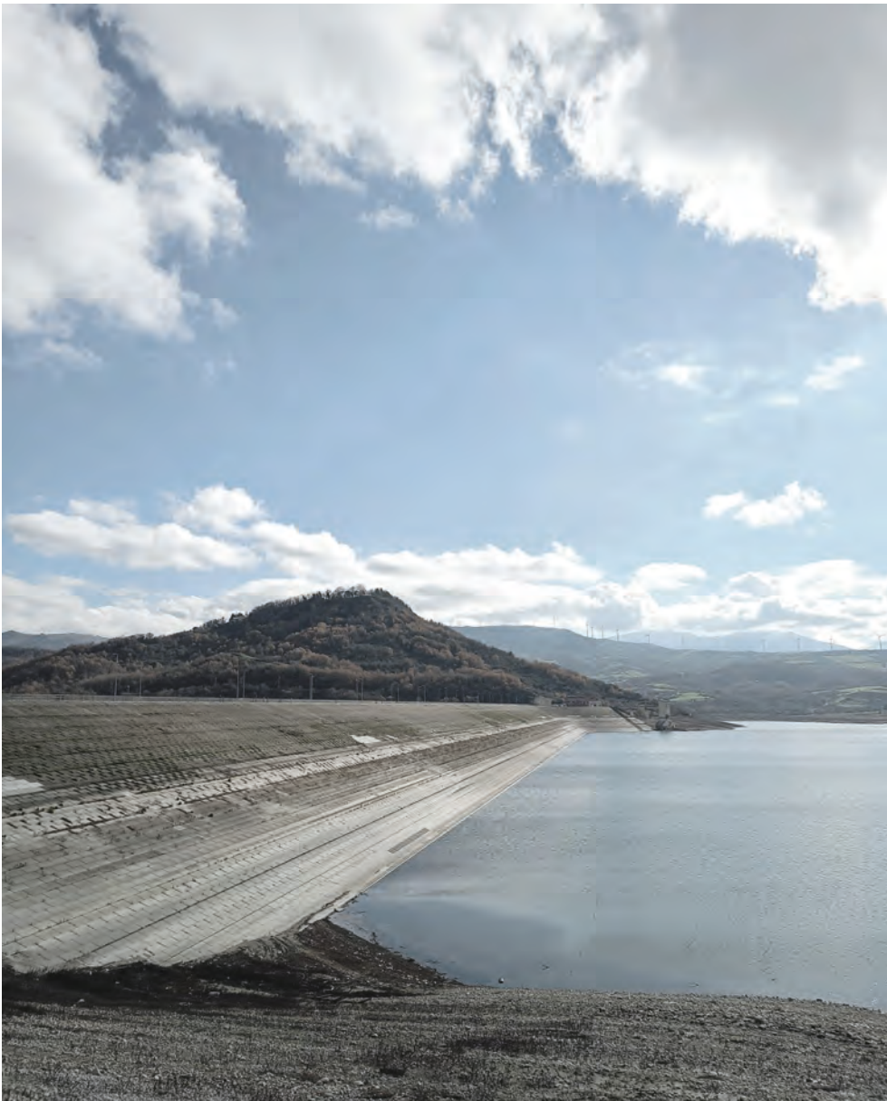
La diga di Conza della Campania. Fotografia di Di Palma B., 2025.
