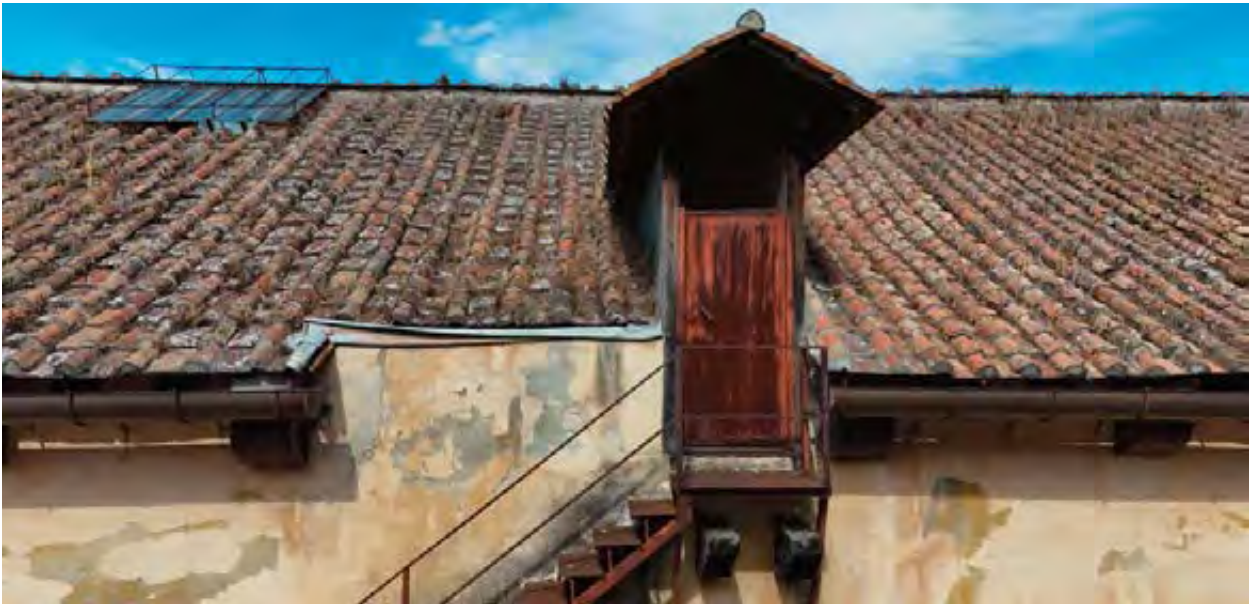
61. Chiesa di s. Maria di Donnaregina. Dettaglio della parte centrale del prospetto ovest, lato via Duomo, con la scala e l'abbaino di accesso al sottotetto
