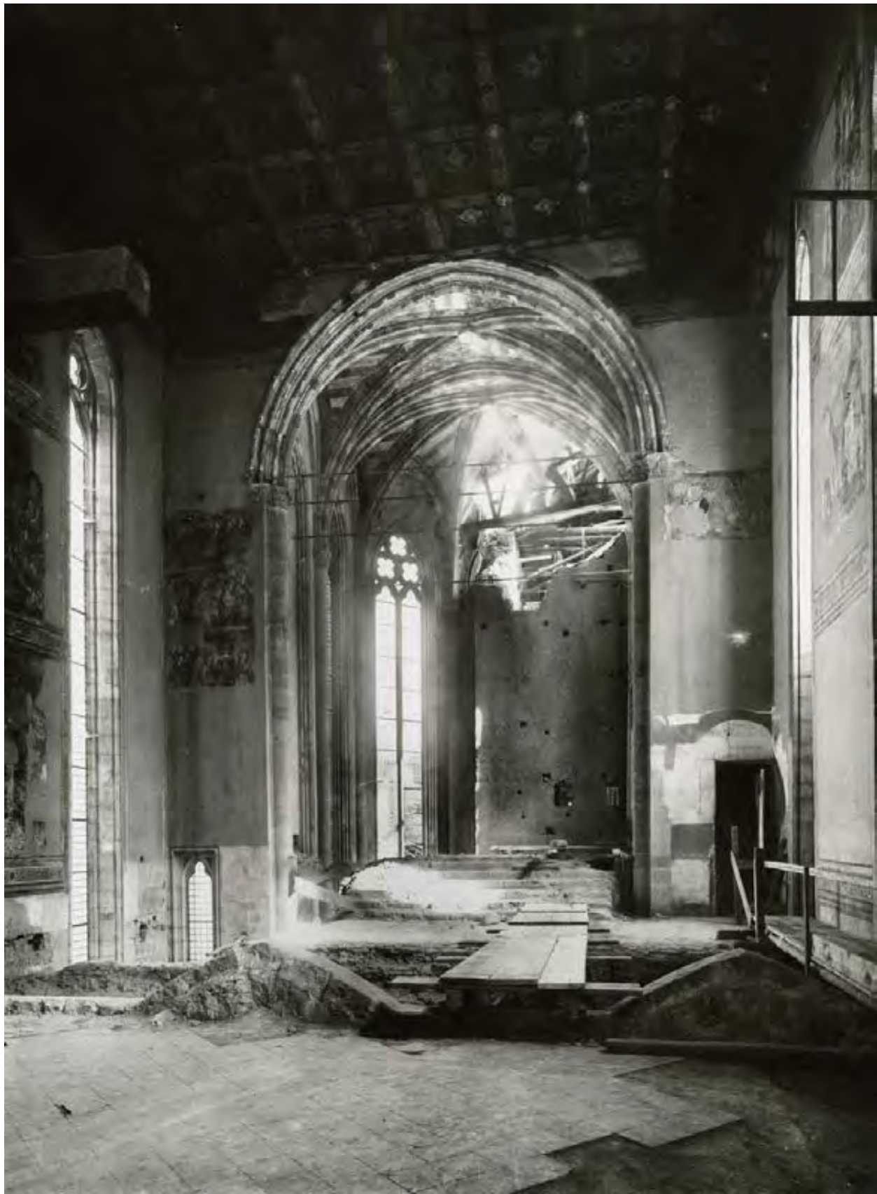
13. Il coro delle monache e la parte superiore dell'abside durante i lavori di restauro (Chierici 1934, tav. CIX)
