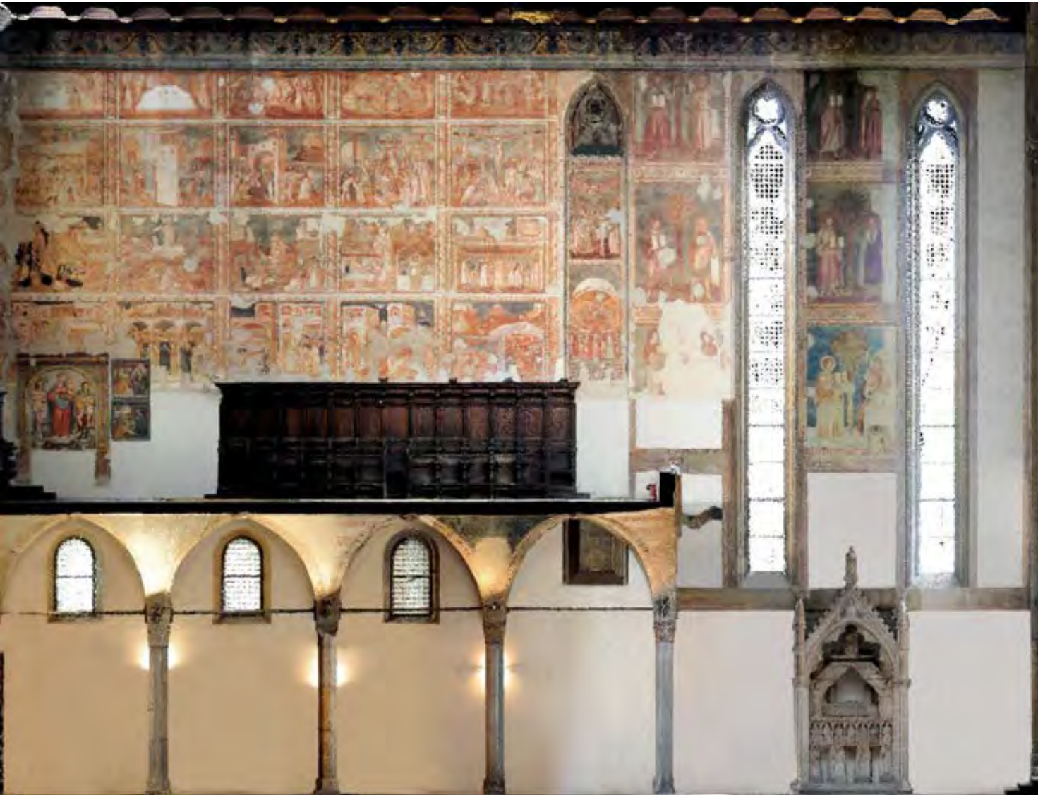
38. Complesso di s. Maria di Donnaregina. Ortofotoproiezione da nuvola dei punti della parete sinistra della chiesa
