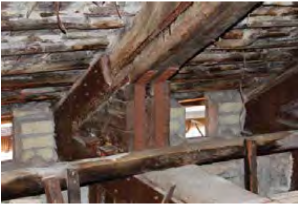
42. Sottotetto della Chiesa di s. Maria di Donnaregina. Le stuccheggature eseguite nel corso dell'intervento di consolidamento del 1996. Il puntone ovest della capriata n. 2
