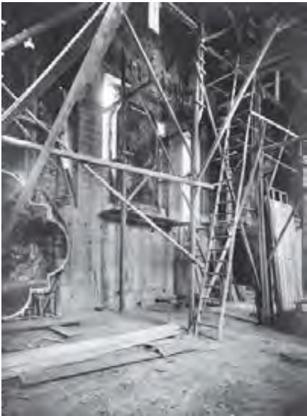
24. Riproduzione fotografica della 'Imbracatura del muro' realizzata per lo spostamento della parete dipinta dal Solimena (AFSABAPNa)
