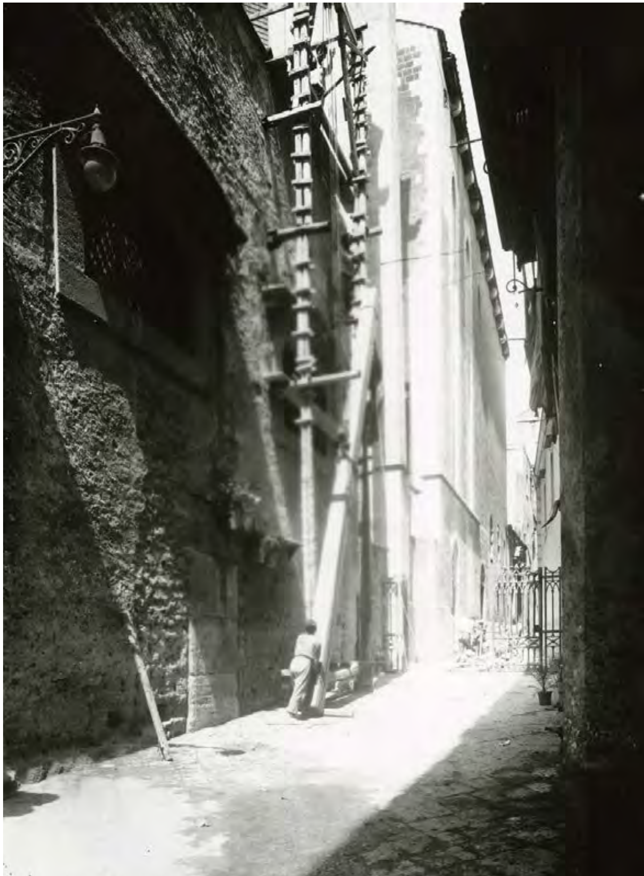
14. I lavori nella parte esterna dell'abside. Demolizione di murature e sottofondazione dei contrafforti (Chierici 1934, tav. CXI)
