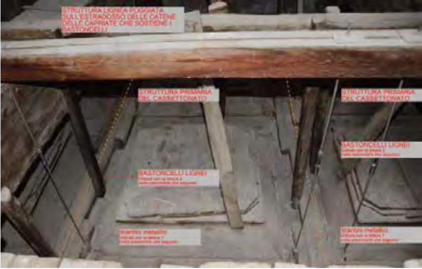
25. Sottotetto della Chiesa di s. Maria di Donnaregina. Particolare dell'estradosso del cassettonato con l'individuazione delle diverse strutture che lo sostengono
