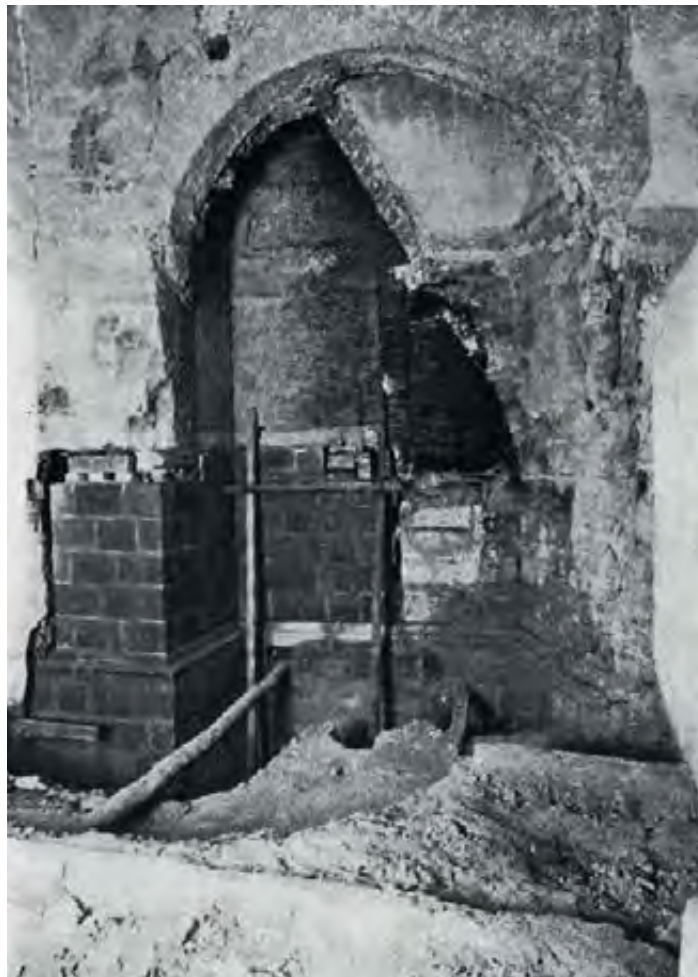
15 I lavori di ripristino dell'abside (AF SABAPNa)
