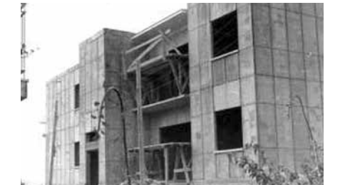
Quartiere Sperimentale Torre Ranieri, 1947-1957, in alto: palazzine in costruzione, a sinistra: sistema Foschini / Experimental Quarter of Torre Ranieri, 1947-1957, up: buildings under construction, left: Foschini system.
