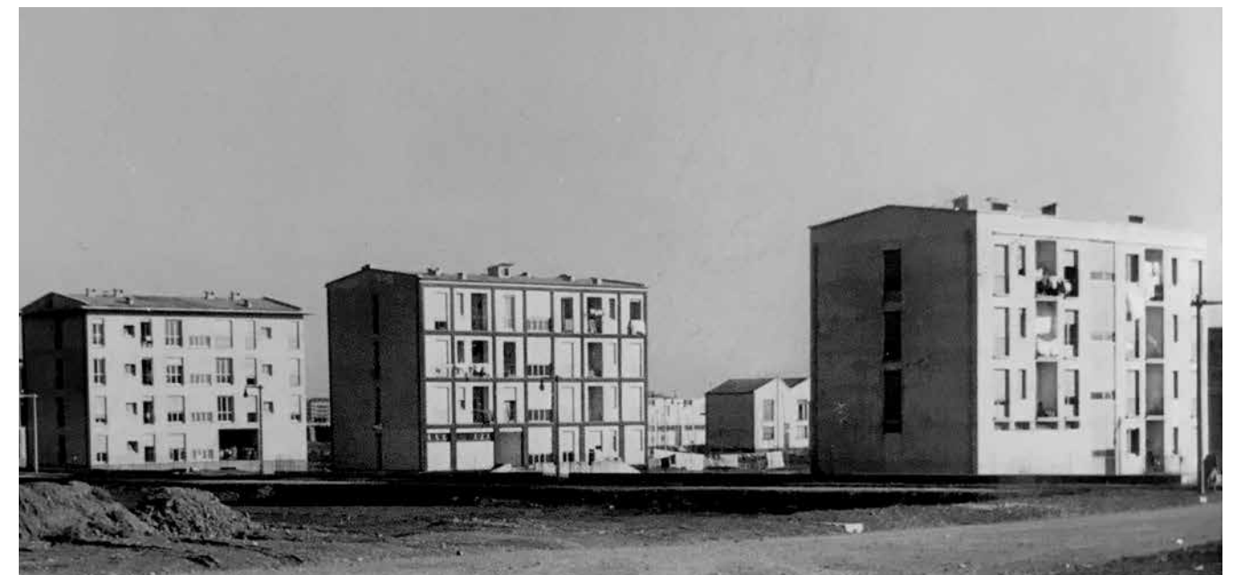
in basso / down Case Sperimentali al QT8, 1947-51. A sinistra ed al centro gli edifici realizzati rispettivamente con i sistemi Gaburri (arch. G. Mucchi) e Ciarlini (progettisti A. Magnaghi, M. Tersigni, e M. Tavarotto) / Experimental Houses at QT8, 1947-51. On the left and in the center, the buildings made respectively with construction systems Gaburri (arch. G. Mucchi) and Ciarlini (designers A. Magnaghi, M. Tersigni, e M. Tavarotto)
