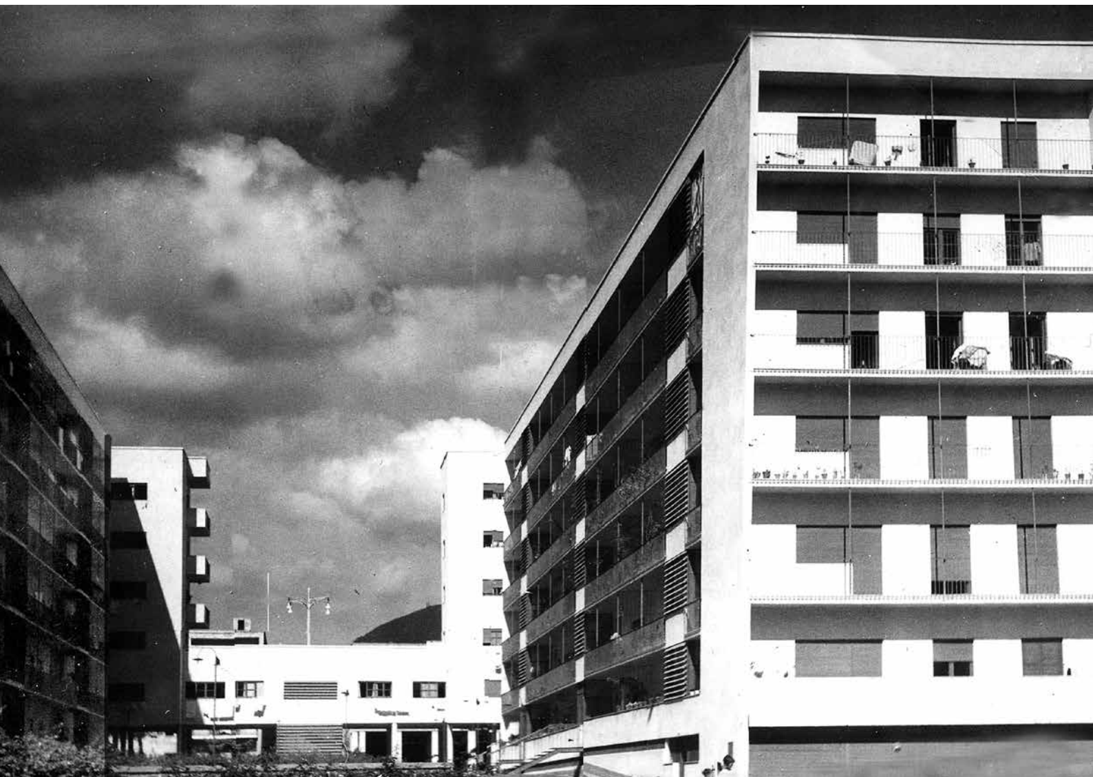
Luigi Cosenza, Carlo Coen, Case popolari in Viale Augusto Napoli, 1949-1950 / Social housing in Viale Augusto, Naples, 1949-1950.
