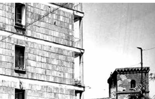
Luigi Cosenza, Francesco Della Sala, Adriano Galli, Quartiere Sperimentale Torre Ranieri, 1947-1957, foto dell'edificio in costruzione, appunti di Luigi Cosenza sull'esito della sperimentazione / , Experimental Quarter of Torre Ranieri, 1947-1957: building under construction and (facing page) Luigi Cosenza's notes on experimental results.
