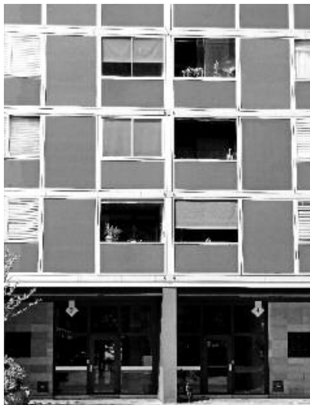
Quartiere satellite Le Lignon, particolare della facciata (foto Paola Ascione, 2011)
