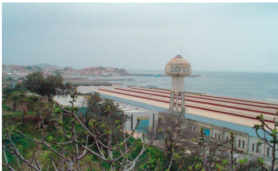
Figura 41: Installazioni industriali sul litorale di Starza
