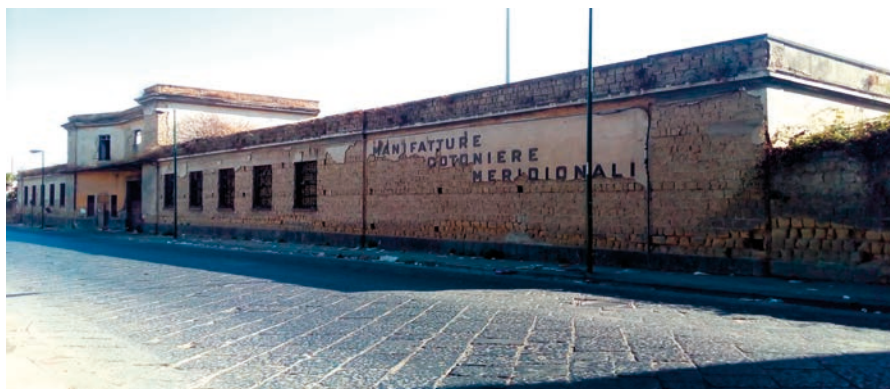
Figura 10: Ingresso MCM in via Caramanico
