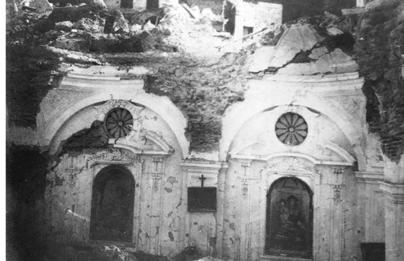
Da sinistra: Casamicciola, chiesa di Santa Maria Maddalena Penitente. Il crollo delle coperture dopo il sisma del 28 luglio 1883 (Mauri, 1883 ca.); Casamicciola, Piazza Maio. Dopo il sisma del 4 marzo 1881, la cupola della chiesa di Santa Maria Maddalena Penitente (Alinari, 1881 ca.)
