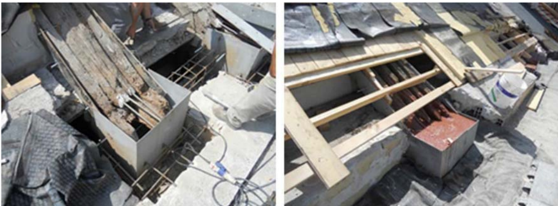
Figura 10. Intervento delle capriate e ricostruzione delle teste ammalorate
