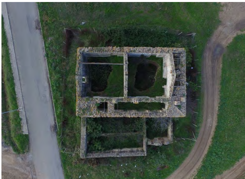
Vista aerea. Sono visibili il crollo della copertura e delle volte dell'edificio.
