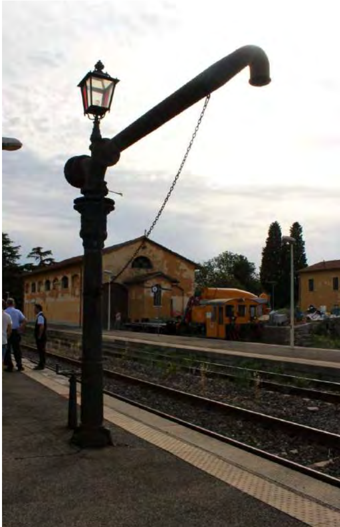
Fig. 2 Torre d'acqua del 1910 alla stazione di Asciano. Foto dell'autore (luglio 2017)
