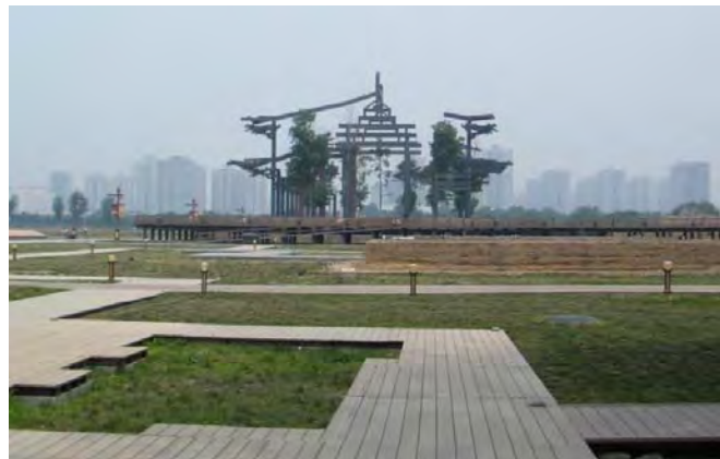
Fig. 3 Daming palace. Soluzioni ricostruttive dei ruderi archeologici: in primo piano dei tavolati lignei, al centro un muretto di terra cruda, sullo sfondo una pedana sagomata con suggerimento di alzato in ferro colorato
