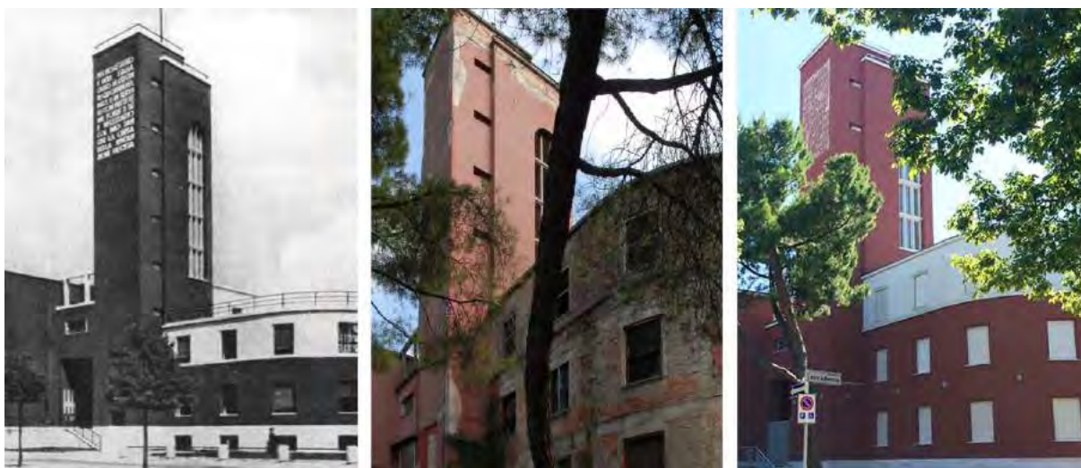
Fig. 2. C. Valle, Casa del Balilla, Forlì. Da sinistra: l'edificio dopo lo smontaggio dei ponteggi in cantiere, 1935-1936 [?] (M. Paniconi 1936, p. 333); dettaglio del prospetto principale prima dell'intervento di restauro, 2011 (Archivio digitale ATRIUM-Forlì); stato di fatto dell'edificio ad intervento concluso, 2016 (Foto G. Favaretto)
