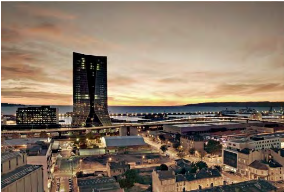
Vista del secondo lotto di Euromediterranée dalla stazione di Saint Charles
