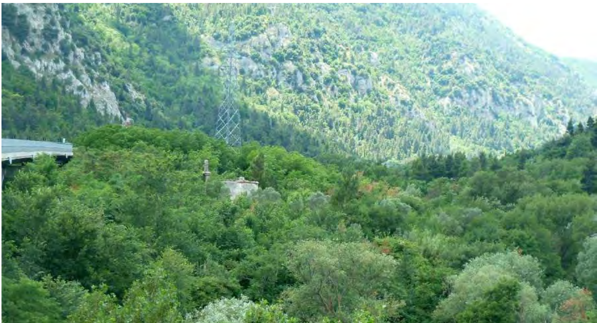
Ruderi della chiesa di S. Martino vicini al viadotto della A25 nei pressi delle gole di Popoli
