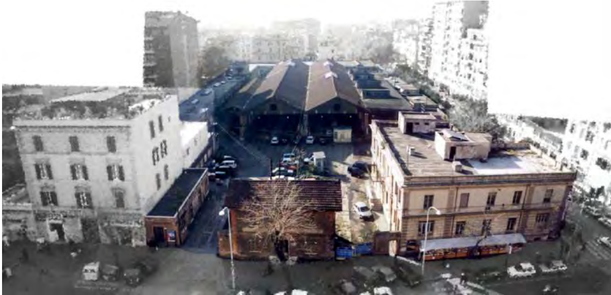
Il deposito S.T.E.F.E.R. all'Alberone nel giugno del 2000: sono ancora visibili la piccola stazione, il palazzetto per la direzione e gli uffici, le rimesse per le vetture, i magazzini e le officine
