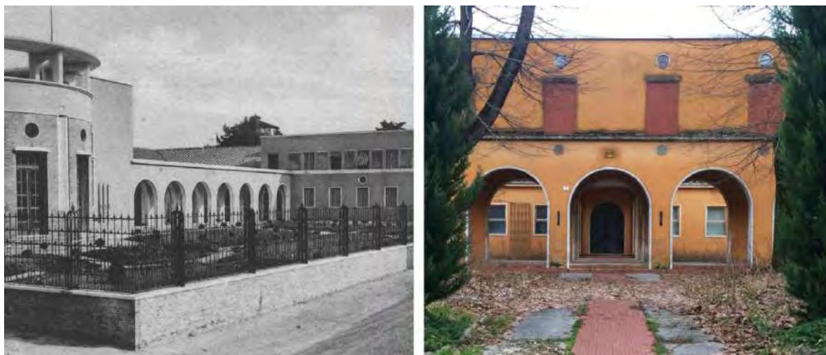
Fig. 3. G. Savini, Asilo Santarelli, Forlì. Da sinistra: l'edificio nel 1936 ( http://atrium.comune.forli.fc.it/linfanzia-a-forli-e-fascismo [25/04/2016]); stato di fatto dell'edificio, 2016 (Foto G. Favaretto)
