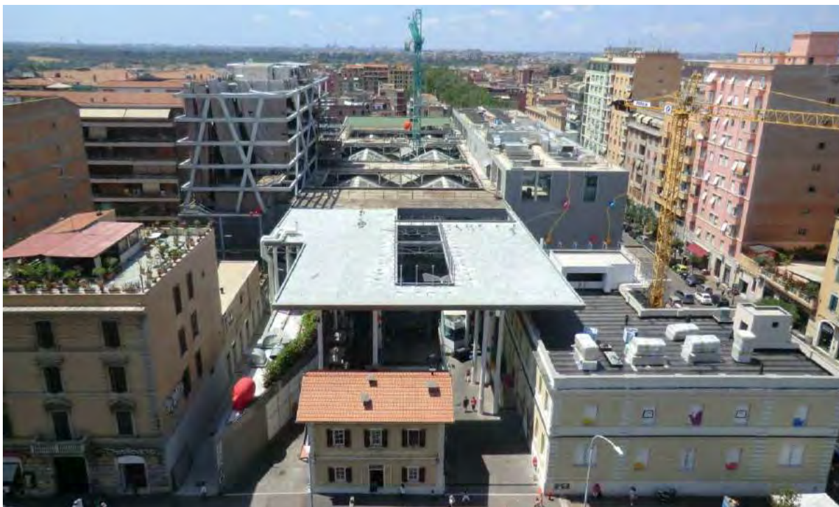
Il nuovo centro commerciale realizzato nell'ex deposito S.T.E.F.E.R.. dell'Alberone (luglio 2017)
