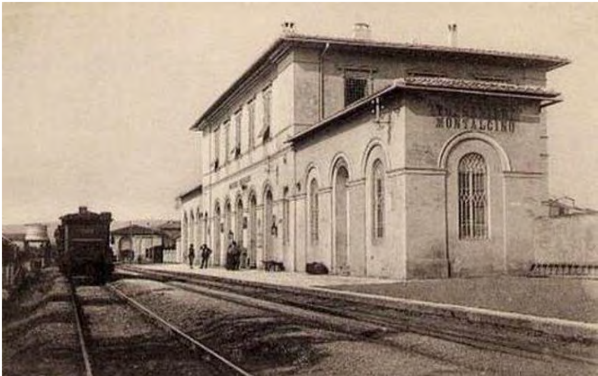
Fig. 3 Stazione di Torrenieri - Montalcino in uno scatto del 1865
