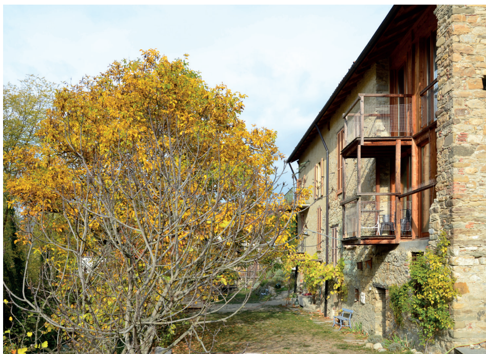
Prospetto sud-ovest dell'edificio principale. Foto di studio Albori
