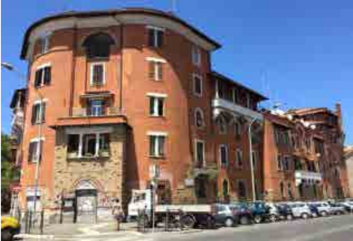
P. Marconi, edificio semintensivo, lotto VIII (1923-1926), Garbatella
