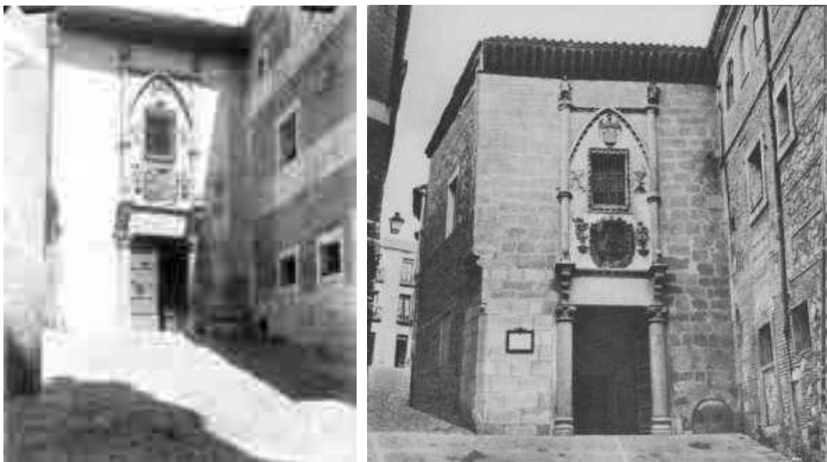
Posada de la Hermandad. Izquierda, en torno a 1920-1930, IPCE WUN-04299. Derecha, en torno a 1860, tras la intervención de González Valcárcel y el picado de los revestimientos, de la Posada y del edificio adyacente AGA 26/00311
