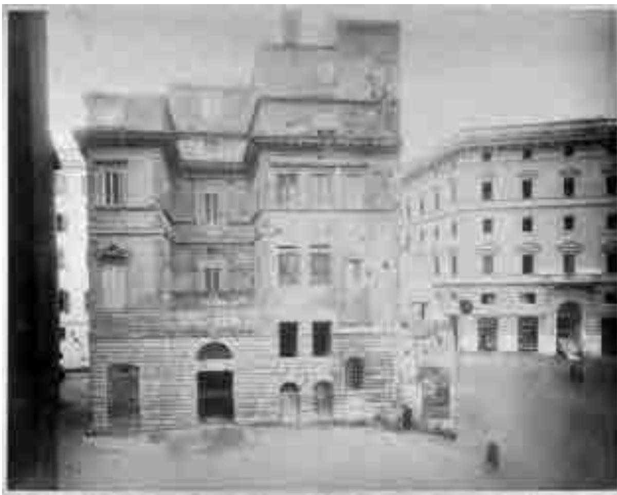
Vista del palazzetto alla fine del XIX secolo, dopo le demolizioni per l'apertura di Corso Vittorio Emanuele II. Esso appare ancora segnato dalle superfetazioni e dal ballatoio costruito sopra il muro del cortile. Museo di Roma, Roma, AF419
