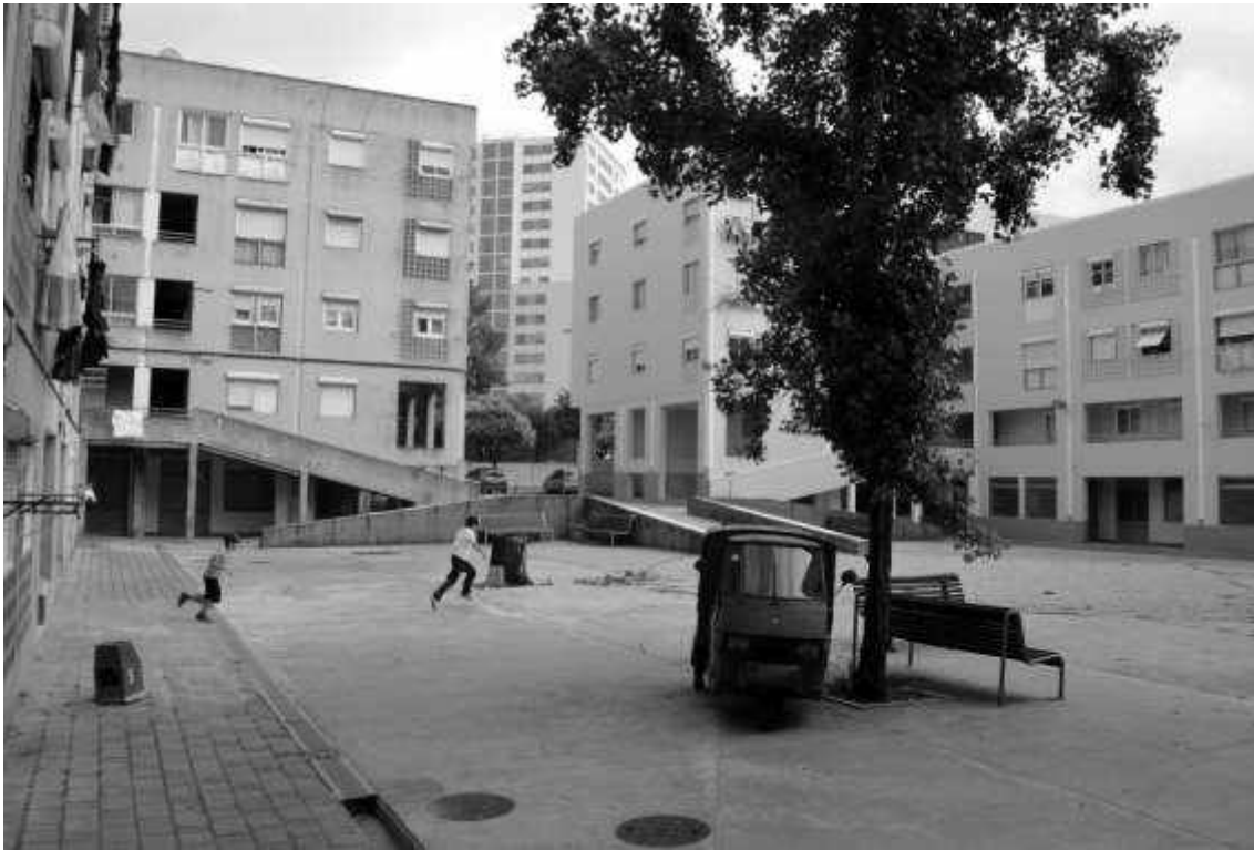
Fonsecas e Calçada Courtyard
