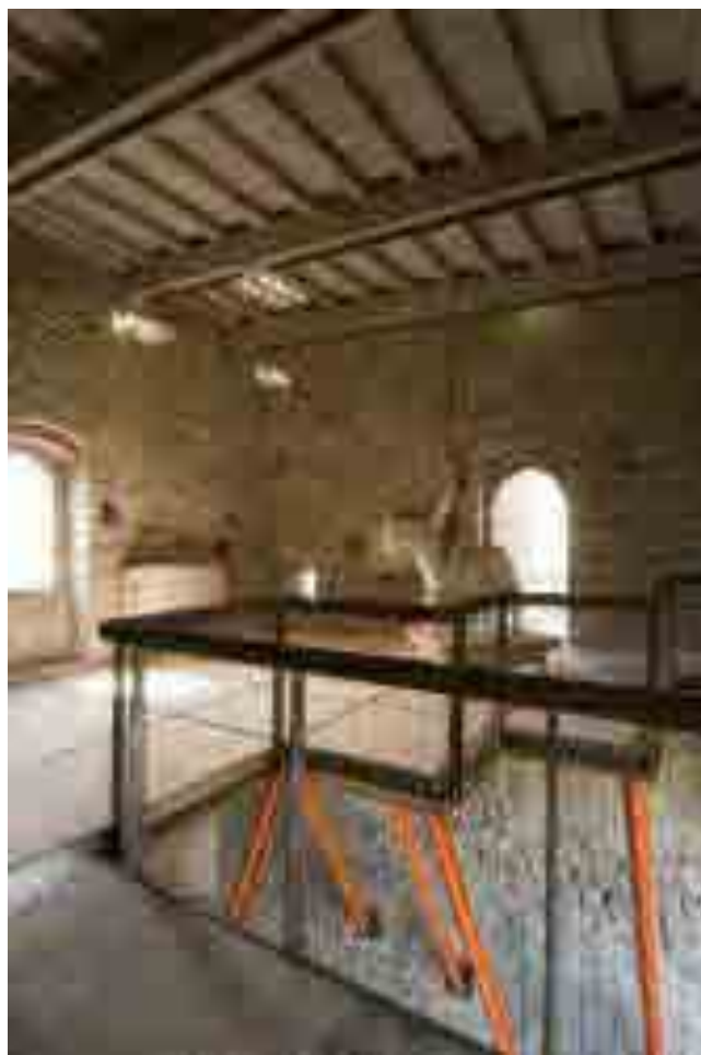
L'impalcato e le saette nella Torre dell'Orologio, ph. S. Benaglia 2007, Archivio di Carlo Scarpa, Museo di Castelvecchio, Verona.
