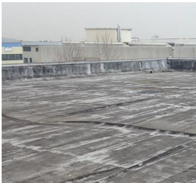
Figura 2 – condizioni di conservazione del manto impermeabile
