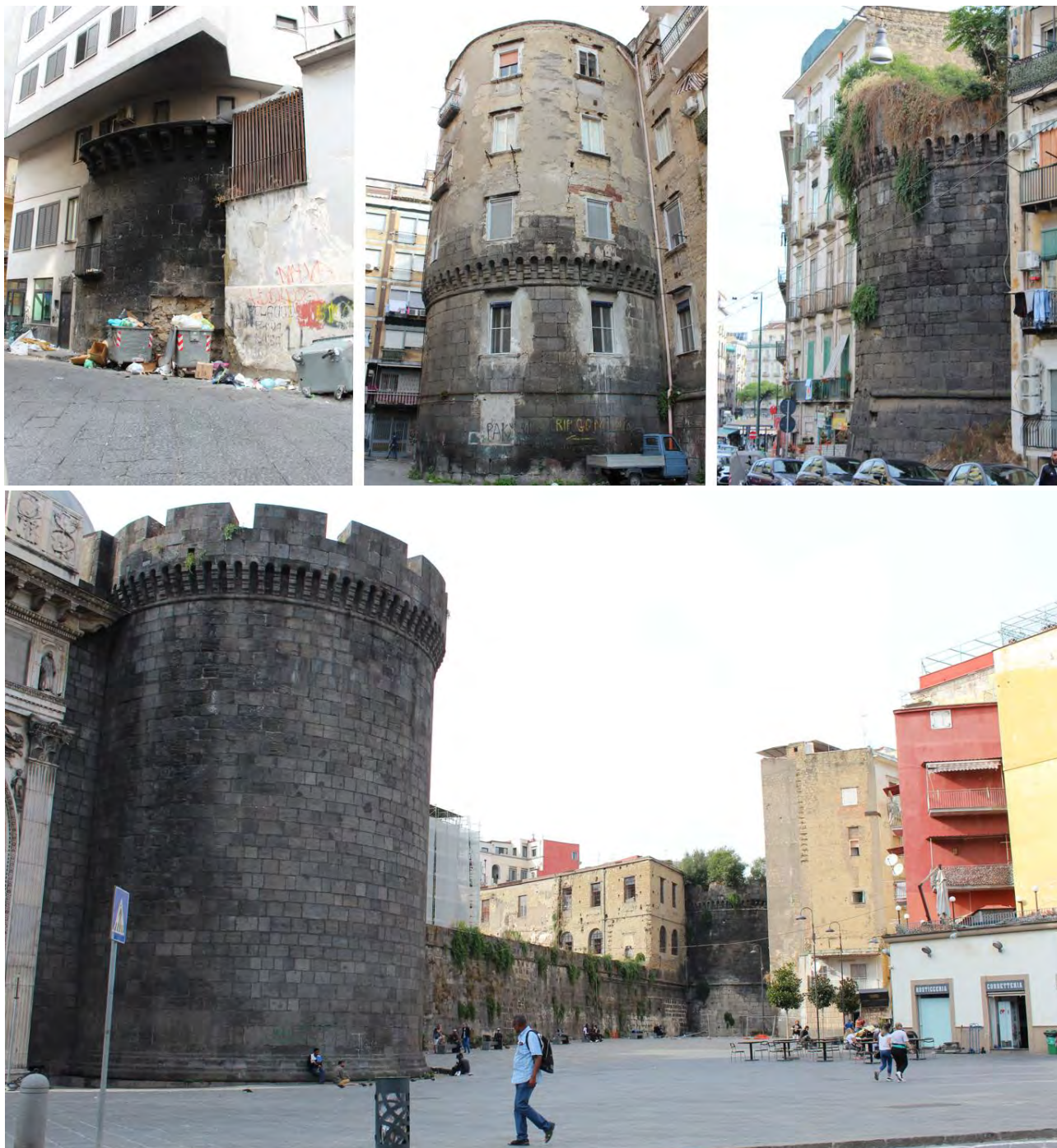
4: Le torri superstiti nell'area di piazza Garibaldi e di Porta Capuana. 4a. La Torre Aragona. 4b: La Torre Gloria. 4c: La Torre S. Anna. 4d: Porta Capuana. Purtroppo, le condizioni di conservazione delle tre torri sono davvero critiche.
