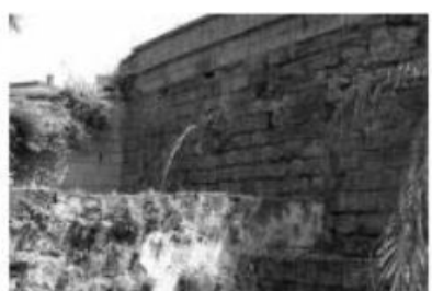
Fig. 6 Giardino di Palazzo Cocozza di Montanaro. Canaline in tufo a cielo aperto che convogliavano le acque verso il boschetto e l'aranceto. La vasca di accumulo d'acqua originariamente servita dall'Acquedotto Carolino.
