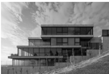
Fig. 4 -Edificio 5529, Punta Gorda, Montevideo .
