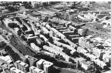
La Loggetta, veduta aerea.
