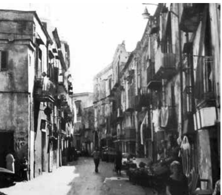
Le cortine edilizie su via Napoli prima dell'intervento.
