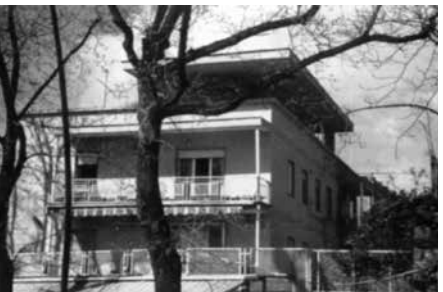
Palazzina 7 realizzata con muratura in getto di calcestruzzo.
