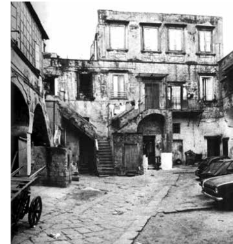
Interno della corte su via Napoli n. 40 prima del progetto di recupero.
