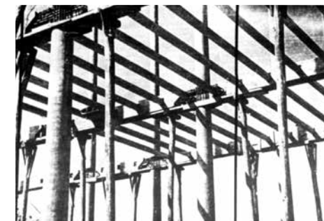
Soluzione con pilastri in cemento armato prodotti in officina.
