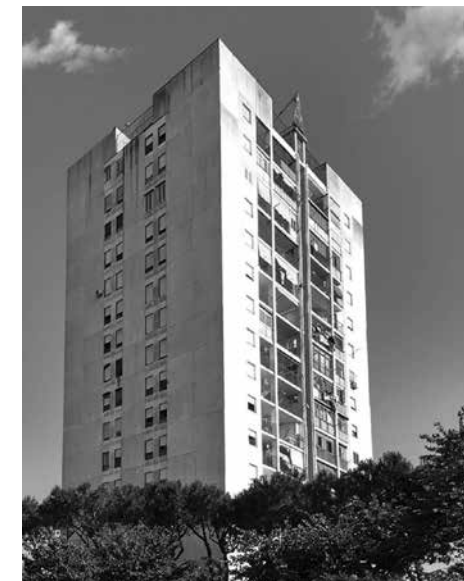
Comparto 9, torre residenziale, prospetti nord-est e sud-ovest 2019.
