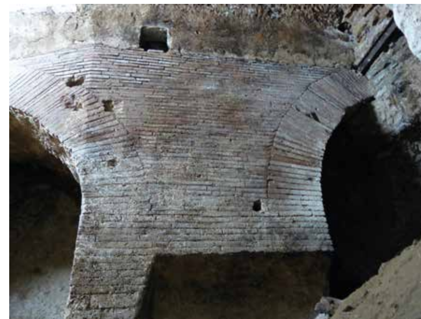
Fig. 6 - Piloni di sostegno dell'acquedotto del Serino (I sec. a.C.)
