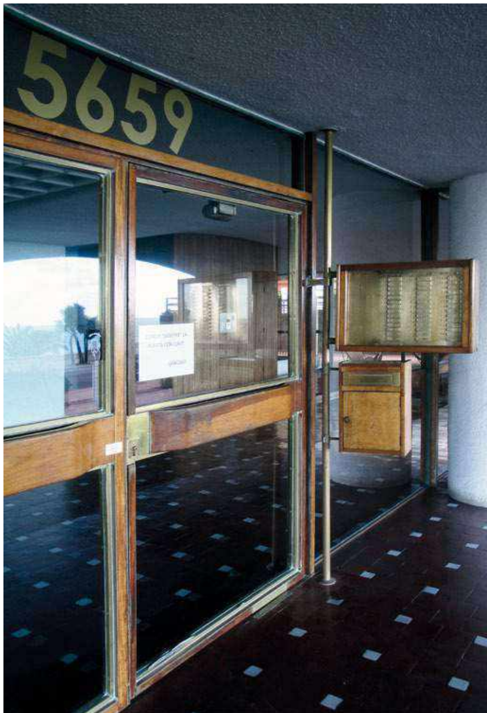
Ingresso all'edificio, stato attuale
