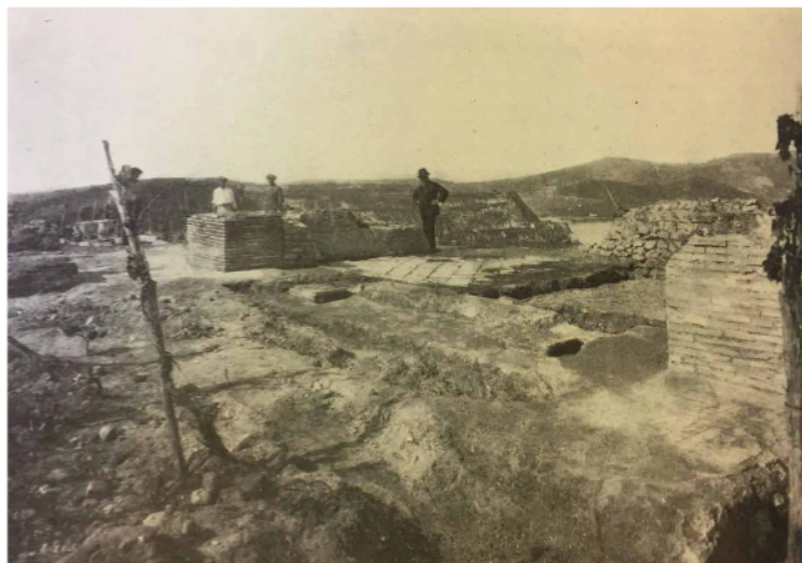
Fig. 10 Operai al lavoro durante gli scavi del 1919 (Levi 1922).
