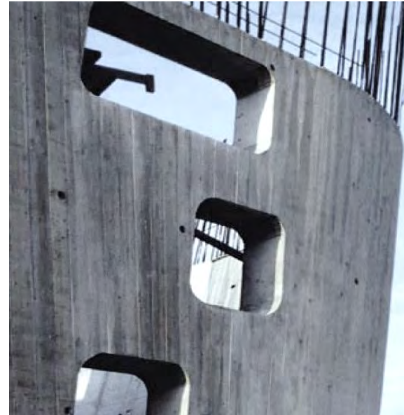
Fig. 111 Dettaglio parete in SCC in costruzione / SCC wall detail under construction
