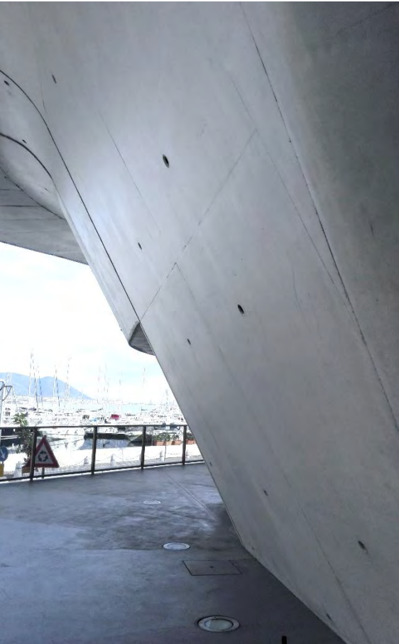
Fig. 112 Parete in SCC della Stazione Marittima di Salerno / SCC wall of the Maritime Station
