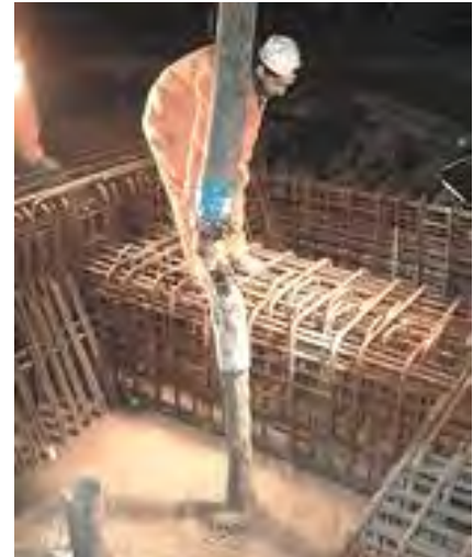
Figg. 81 e 82 Il ponte di S. Calatrava a Venezia: getto del calcestruzzo autocompattante nelle prove preliminari e dopo la correzione della composizione / The "Bridge by S. Calatrava in Venice: self compacting concrete jet in the preliminary tests and after the correction of the composition
