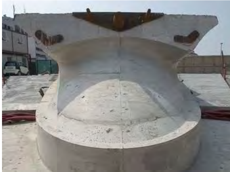
Fig. 80 Spalla del ponte di S. Calatrava a Venezia dopo lo scassero / Shoulder of the Bridge by S. Calatrava in Venice after the formwork removal
