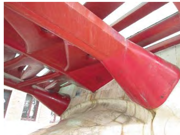
Fig. 77 Spalla del ponte della Costituzione rivestita / Shoulder of the Bridge by S. Calatrava "covered
