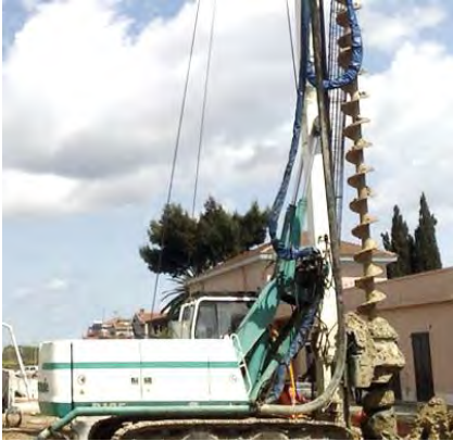
Fig. 127 Estrazione del terreno nella realizzazione dei pali a elica continua / Soil extraction in the construction of Continuous Flight Auger piles
