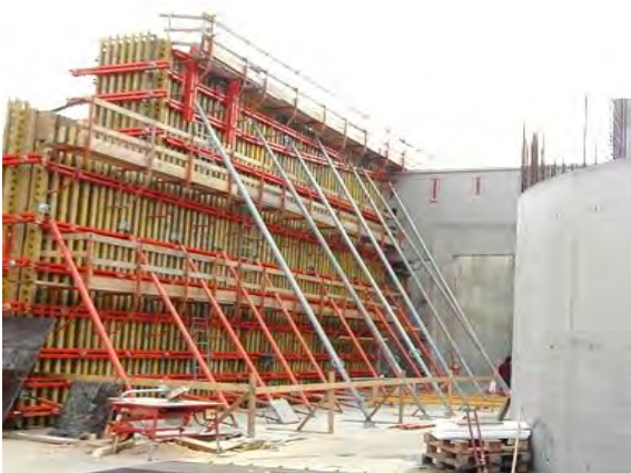
Fig. 108 Rimozione dei casseri nel MAXXI di Roma / Formworks removal in the MAXXI in Rome
