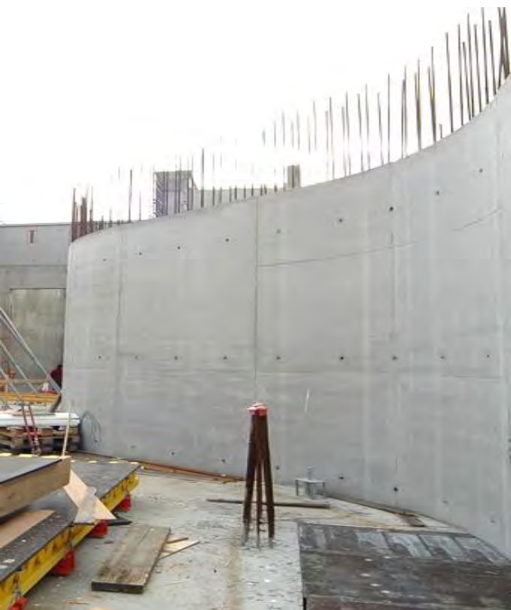
Fig. 109 Parete del MAXXI di Roma appena scasserata / MAXXI wall after the formworks removal
