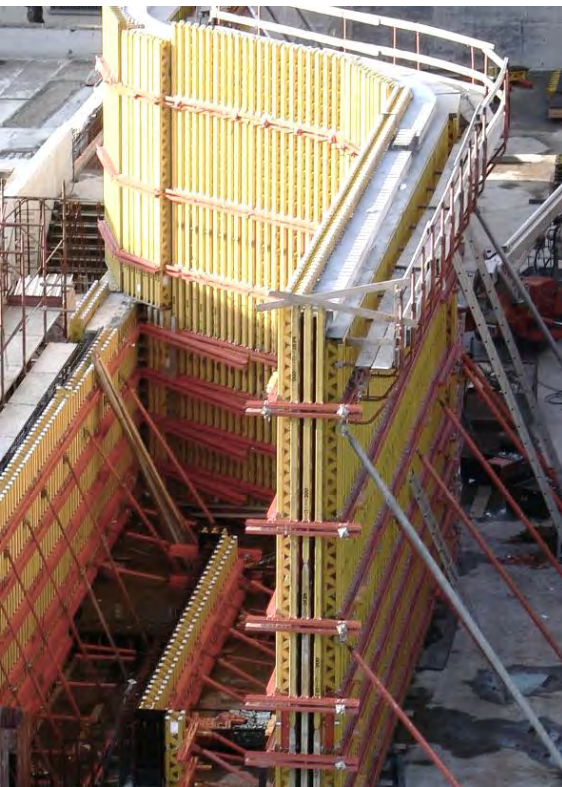
Fig. 86 I casseri del MAXXI di Roma / Formworks of the MAXXI in Rome
