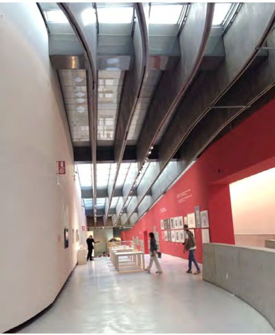
Fig. 117 Interno del MAXXI con travi a lamella in calcestruzzo a faccia vista / MAXXI interior with reed beams in concrete to face
