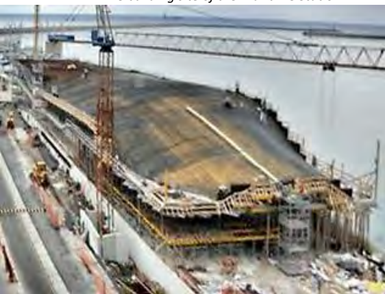
Fig. 113 Il cantiere della Stazione Marittima / The building site of the Maritime Station
