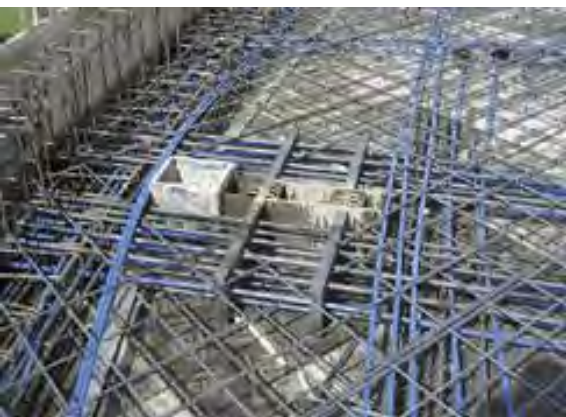
Fig. 72 Armature prima del getto di SCC nel World Trade Center di Foster a San Marino / Armors before the SCC jet in the World Trade Center by Forester in San Marino
