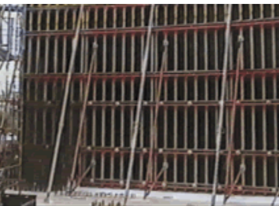
Fig. 71 Casseri SCC della chiesa di S. Pietro Apostolo (PE) / SCC formwork of the Church St. Peter the Apostle (PE)
