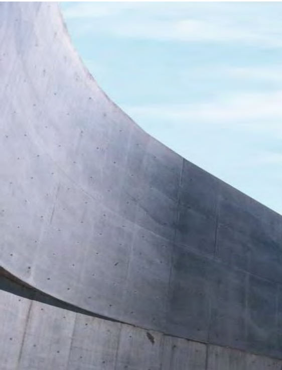
Fig. 116 Il calcestruzzo a faccia vista sulla superficie esterna del MAXXI / The concrete to face on the external surface of the MAXXI
