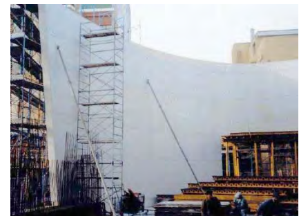
Fig. 21 La vela in calcestruzzo autocompattante bianco della chiesa di San Pietro Apostolo a Pescara / The sail made in white self compacting concrete of the church of St. Peter the Apostle in Pescara, 2000
