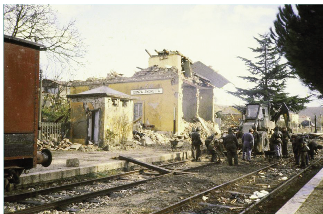
Fig. 2 – Le macerie della stazione ferroviaria di Conza Andretta, 1980
