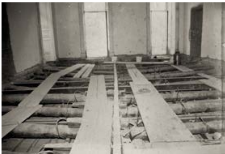
Figure 65-66. Lavori nel salone, fine anni Ottanta. Sostituzione delle travi lignee con assi in ferro, FCAPNa, archivio sezione amministrativa
