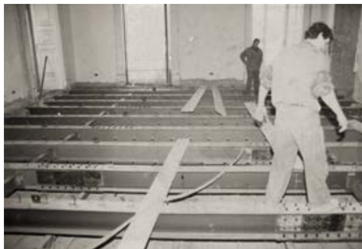
Figure 65-66. Lavori nel salone, fine anni Ottanta. Sostituzione delle travi lignee con assi in ferro, FCAPNa, archivio sezione amministrativa
