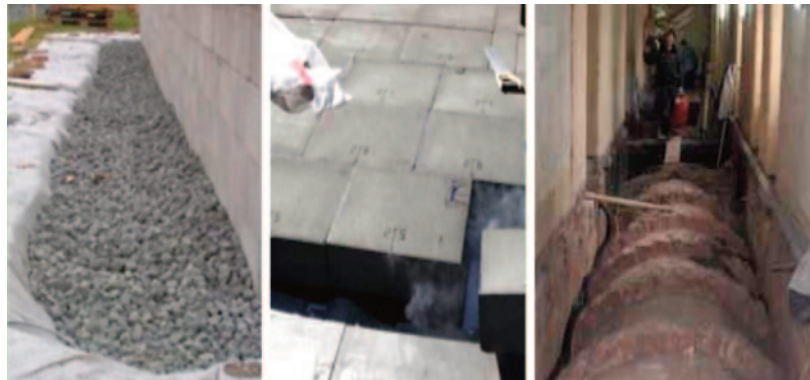
Figure 10. Applications with the foam glass: a) hot drainage system, b) flat roof insulation, c) light material for filling of the masonry vaults / Applicazioni con il vetro cellulare: a) sistema di drenaggio a caldo, b) isolamento del tetto piano, c) materiale leggero per il riempimento delle volte in muratura
