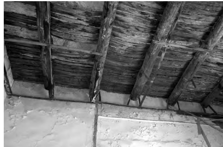
Elemento tecnico copertura, intradoss / Technical element, roof.
