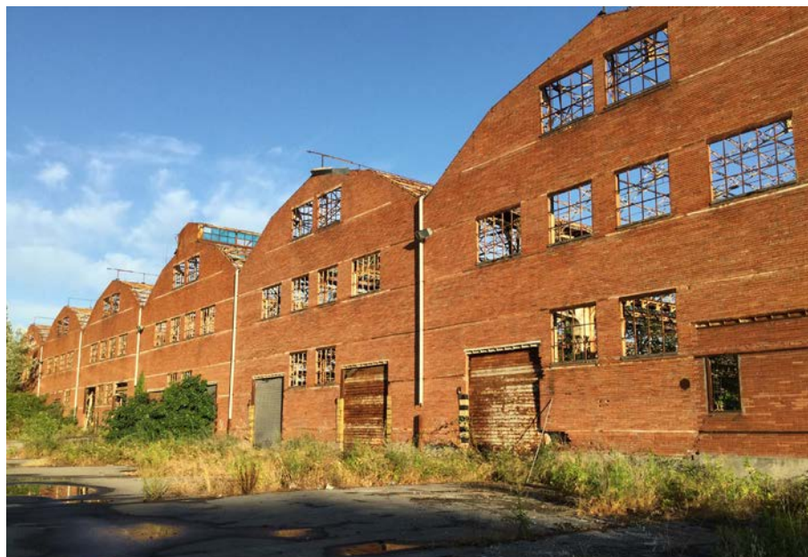
FIGURA 3.4 – Caserta, strutture dismesse dello stabilimento industriale Saint Gobain FONTE: foto dell'Autore
