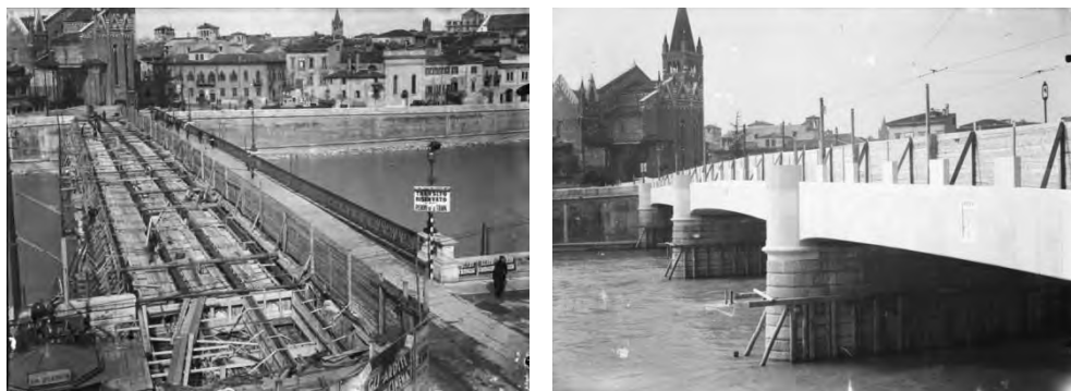
Fig. 2 – Costruzione di ponte delle Navi, 1934-36: il cantiere e il ponte ultimato (BCVr).
