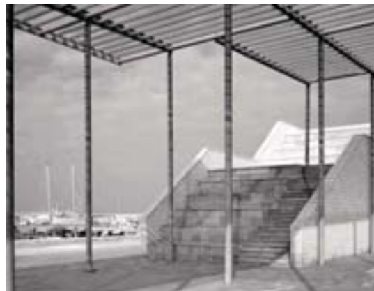
Particolare della scalinata
