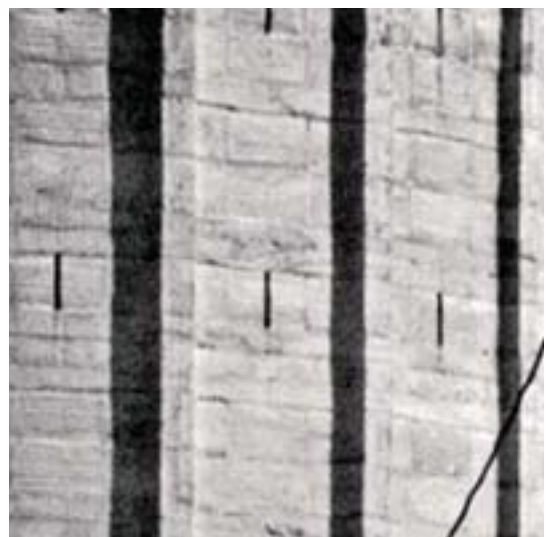
Foto storica, particolare della facciata
