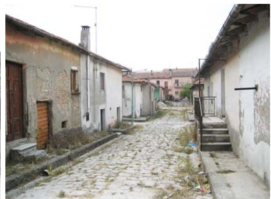
Fig. 4 - Aquilonia. Le “casette asismiche” ancora esistenti. Fonte: foto dell'autore.
