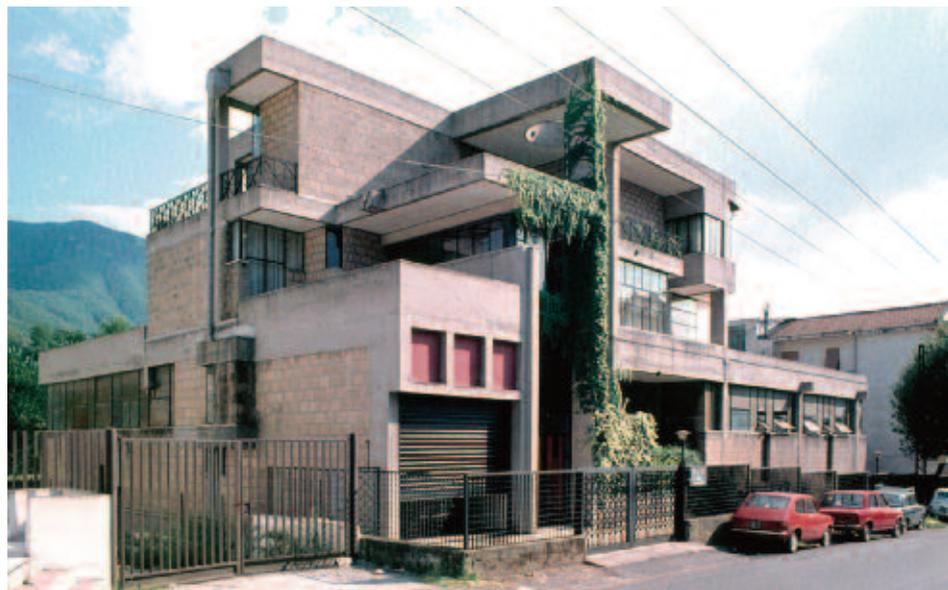
Casa con officina per la lavorazione del ferro a Baronissi, Salerno, 1965. Quest'opera è una felice applicazione dell'unione fra telaio strutturale in calcestruzzo a vista e compagini in blocchi di tufo. Per verificare la composizione evitando la compiacenza del segno, fece lo schizzo prospettico con la mano sinistra e mi disse che secondo Leonardo "con la mano sinistra si disegna con il cuore, con la mano destra con la memoria".
