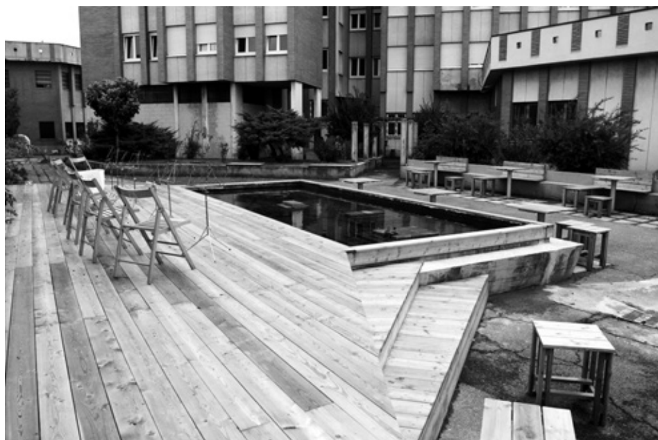
Area 2 - Spazi per il personale, la situazione dopo l'intervento
