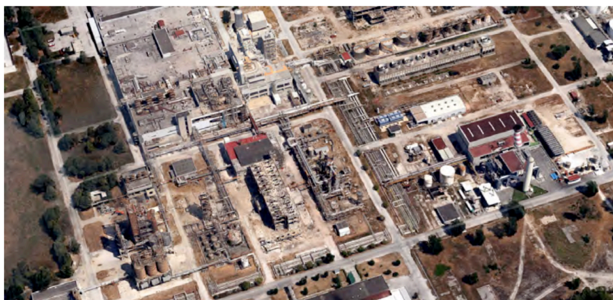
Figura 2 | Area Asi di Acerra. Area dismessa dell'ex Italsider (Google Earth).
