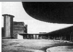
1937_a. mazzoni_stazione ferroviaria_siena
