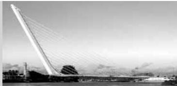
1992_s.calatrava_alamillo bridge e cartuja viaduct_siviglia
