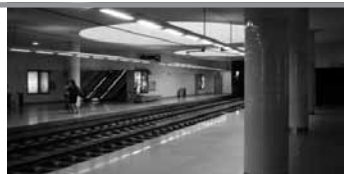
2002_a. siza, e. souto de moura_metro (apertura)_stazione casa da musica_oporto
