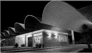
1974_e. dieste_bus terminal_salto
