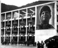
1932_terragni g._iniziano i lavori della casa del fascio
