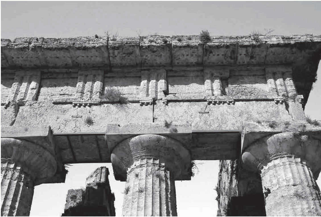
Paestum, tempio di Nettuno, particolare dell'intervento di consolidamento dell'architrave della fronte meridionale portato avanti da Ulisse Rizzi negli anni Cinquanta del XIX secolo (foto Stefania Pollone, 2014)
