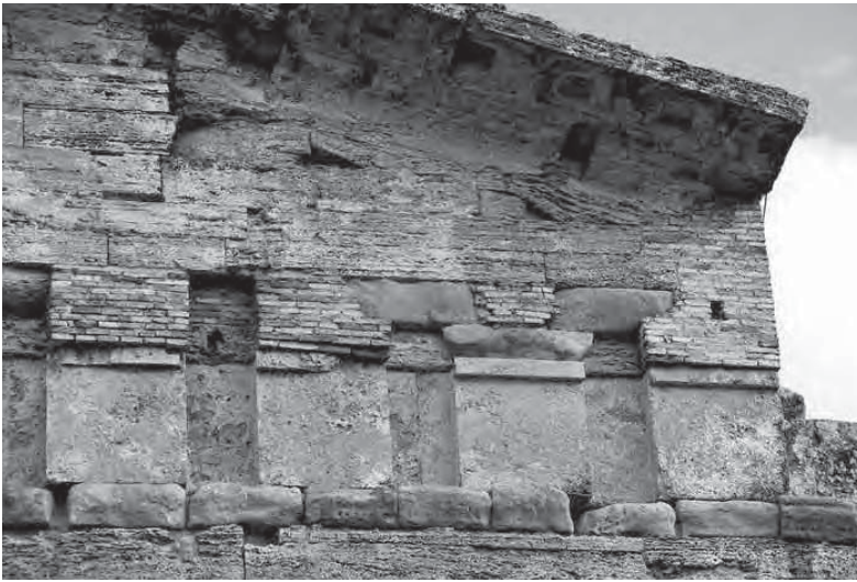
Paestum, tempio di Atena, particolare delle integrazioni in muratura di laterizio eseguite, sul timpano occidentale, da Ciro Cuciniello negli anni Trenta del XIX secolo (foto Stefania Pollone, 2014)
