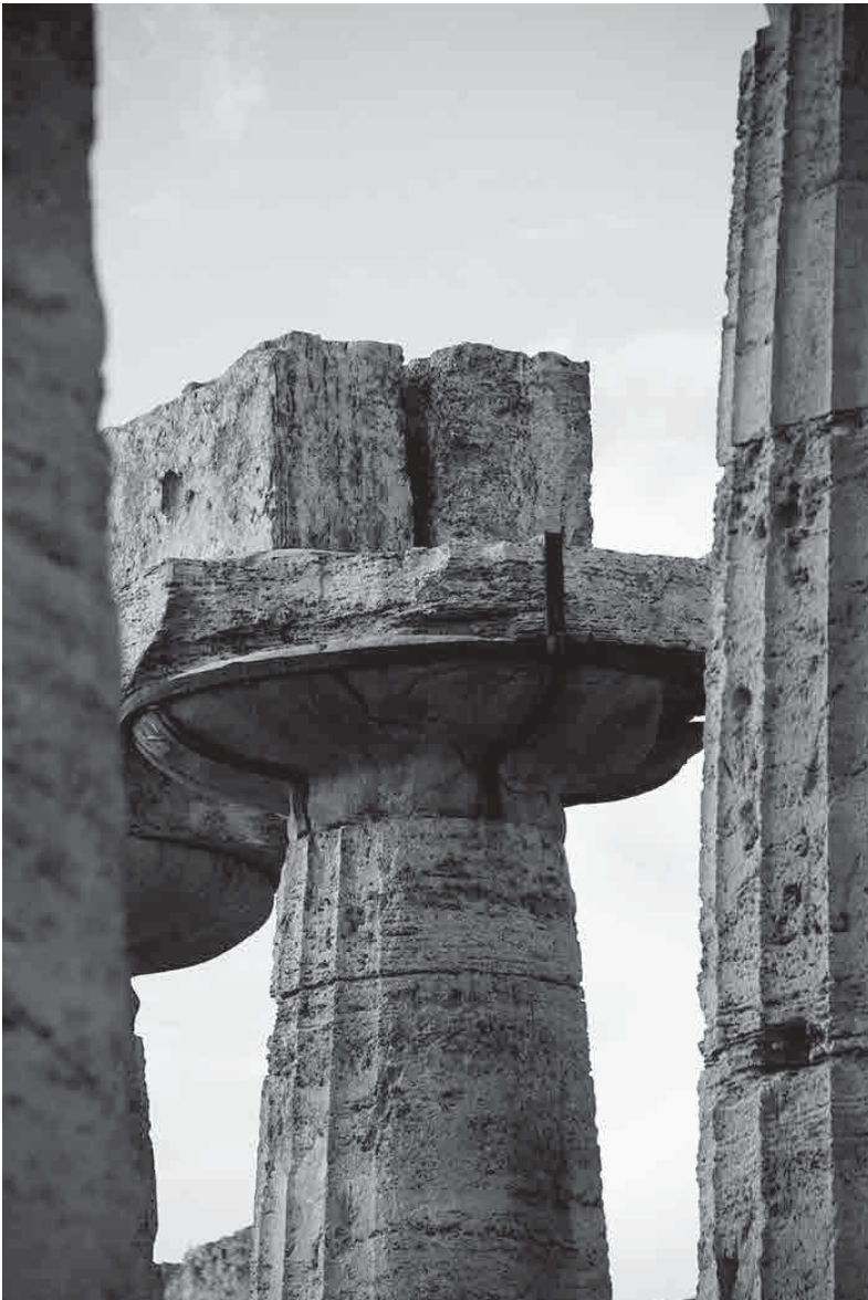
Paestum, tempio di Hera (cosiddetta Basilica). Cerchiature metalliche del capitello di una colonna dell'ordine interno poste in opera da Ulisse Rizzi negli anni Cinquanta del XIX secolo (foto Stefania Pollone, 2014)
