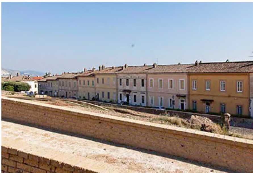
Figura 2: Le case operaie a schiera delle Seterie di San Leucio
