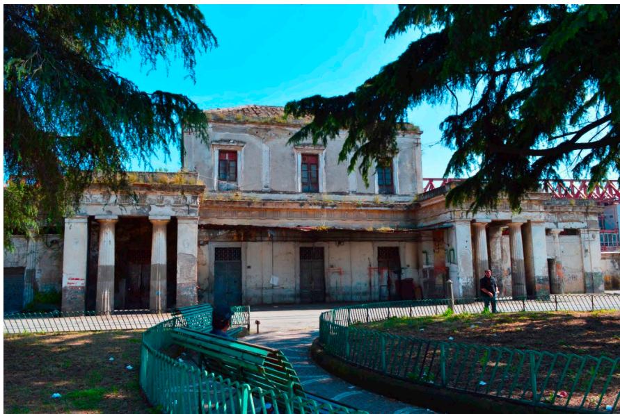
Figura 11: Ex Dogana di Poggioreale (prima dell'inizio dei lavori)
