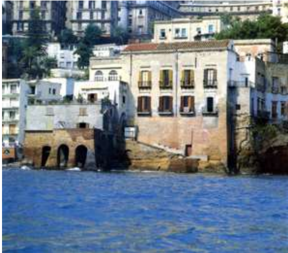
Fig. 3: Villa Mazzotti costruita sui resti di un baluardo difensivo di età vicereale [De Fusco 1988].
