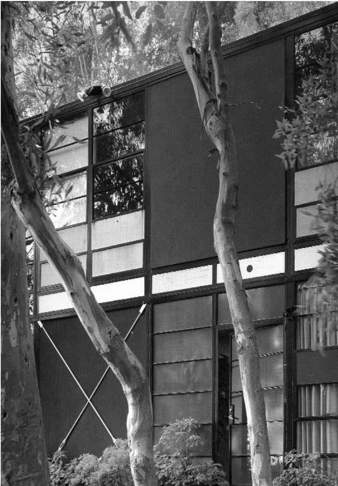
15. C.S.H. n.8. La pelle esterna della casa è realizzata con elementi di piccole dimensioni, vetriati o opachi finiti con stucco colorato, incorniciati da sottili profili della struttura.
