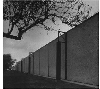
40. Craig Ellwood, *Scientific Data System (S.D.S.)*, El Segundo, California, 1966. Vista laterale dell'edificio con in evidenza la struttura portata all'esterno dell'involucro.
