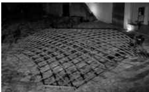
4. Dopo l'assemblaggio la griglia è sollevata da terra e appoggiata su cavalletti per essere deformata
