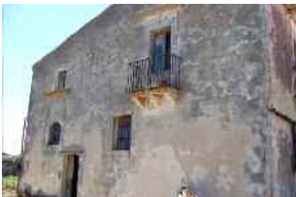
2. Asimmetrie delle aperture in funzione dell'orientamento
