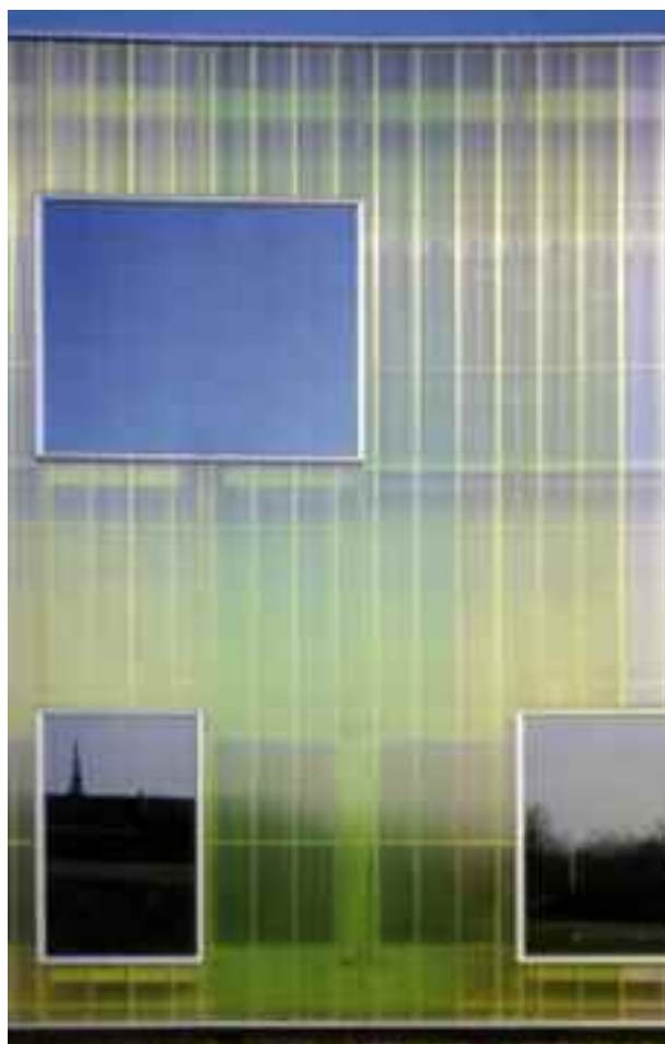
1. Laban Centre a Londra (UK), Herzog & De Meuron, involucro traslucido in lastre di policarbonato alveolare
