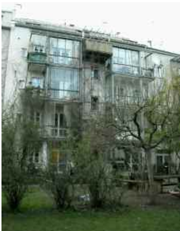
4. Un intervento di retrofit tecnologico ed energetico: casa in Pariser Strasse, Monaco di Baviera.
