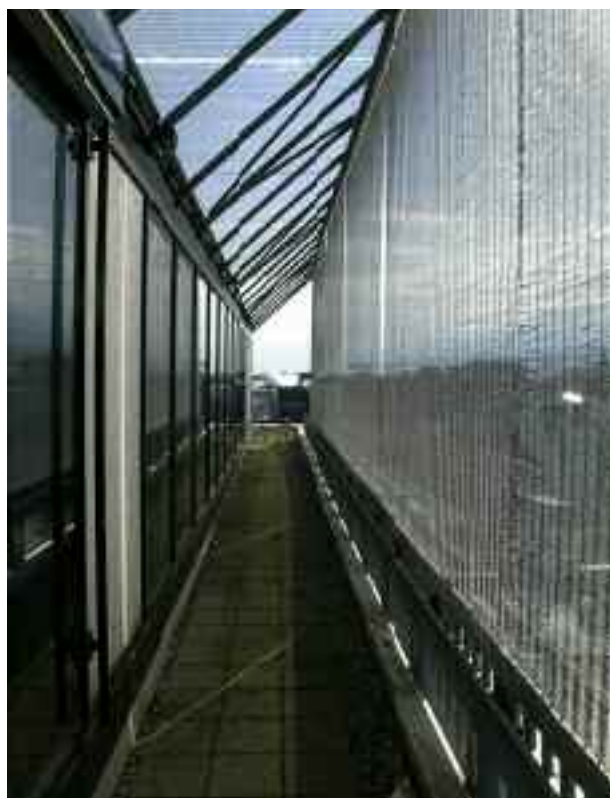
3-4. Rathaus a Innsbruck (A), Dominique Perrault, involucro traslucido realizzato in vetro serigrafato (3) e frangisole esterno in maglia metallica in acciaio color oro (4) (foto di Theo Zaffagnini).
