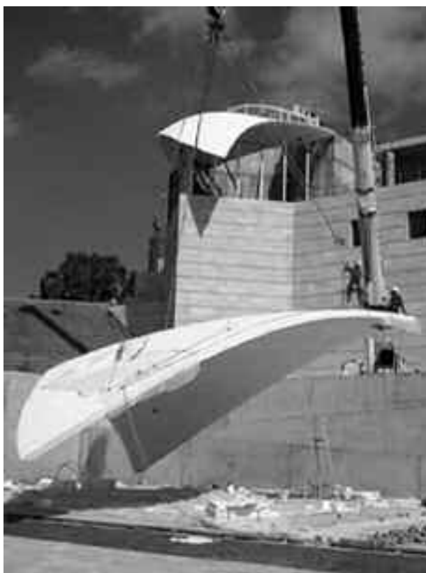
6. Struttura di copertura del Yitzak Rabin center a Tel Aviv (Moshe Safdie, 2005)
