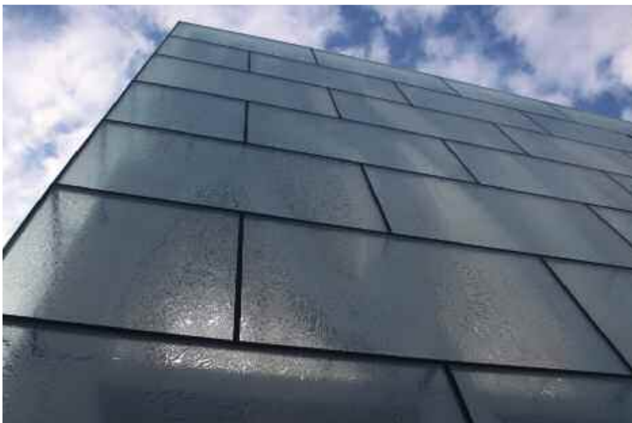
6. Club House Rohner a Fussach (A), di Baumschlager & Eberle, involucro traslucido realizzato in vetro acidato (foto dell'autore).
