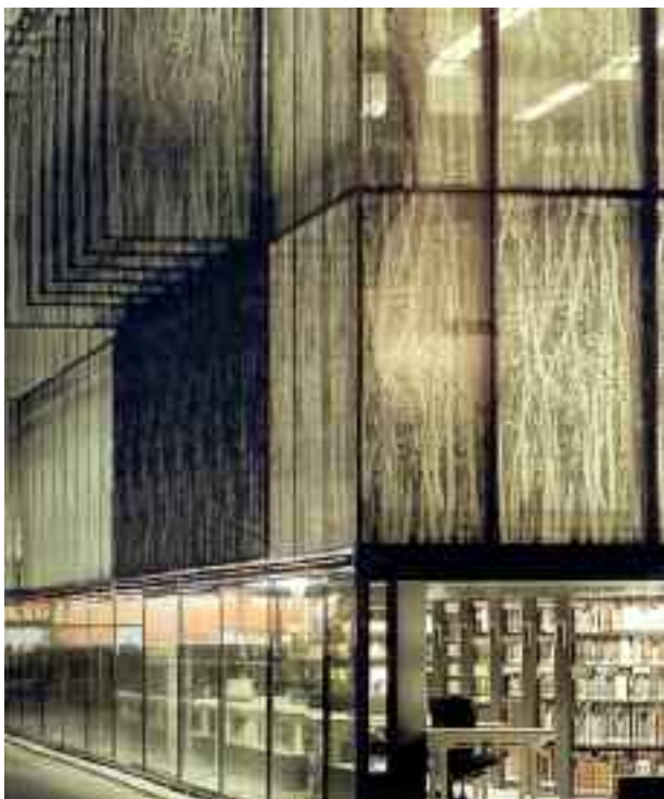
1. Biblioteca universitaria di Utrecht (Wiel Arets, 2004) Particolari del motivo decorativo in facciata
