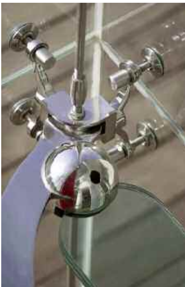
2. Giunto sferico in acciaio inox a disegno realizzato al tornio
