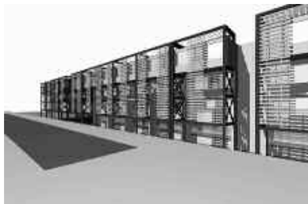
6. Nuovo sistema di scleratura solare su edificio scolastico esistente
