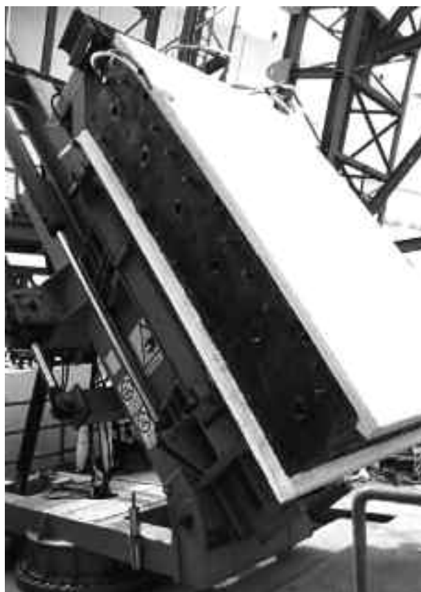
5. Movimentazione del concio in calcestruzzo sul robot per il posizionamento sulle vele
