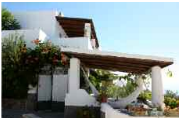
3. Pergolato e veranda in una casa eoliana
