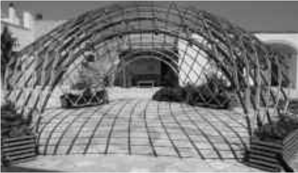
6. Il modulo di grid-shell nella sua configurazione finale a doppia curvatura
