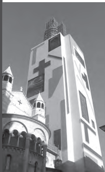
fig. 1: Ghirlandina, campanile del Duomo di Modena in restauro. Rivestimento dei ponteggi di Mimmo Paladino.
