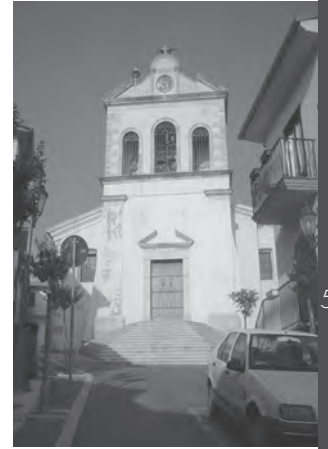
fig. 4: Chiesa di Santa Maria della Consolazione a Paternopoli.
