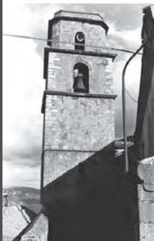
fig. 14: Il campanile di Morra De Sanctis prima del crollo.
