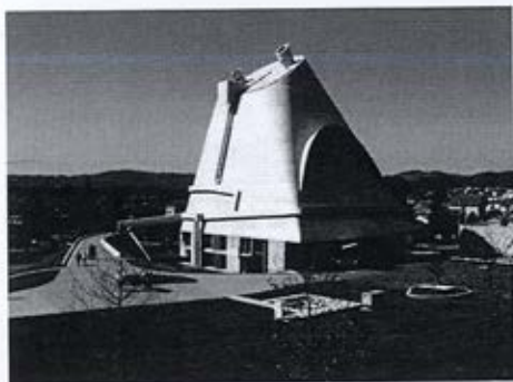
Fig. 25 - Foto dell'ingresso dalla rampa.
