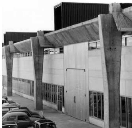
Fig. 13, 14 (sotto) - Stabilimento Olivetti Italia, Scarmagno, 1972. Vista del cantiere durante la posa in opera delle travi principali; vista esterna a progetto ultimato.
