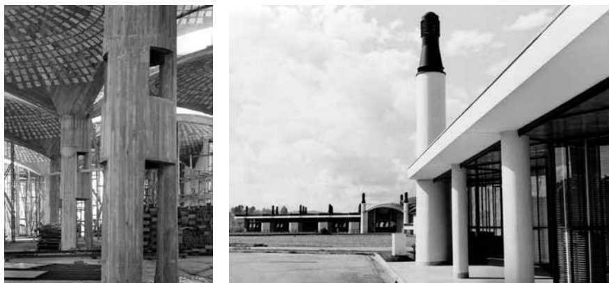
Fig. 10, 11 - Fabbrica Olivetti Brasile, San Paolo, 1956-1961. Pilastro cavo durante il cantiere e a progetto ultimato.
