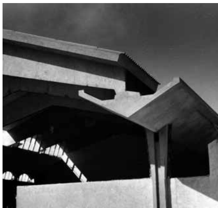
Fig. 3 - Fabbrica Cedis, Palermo, 1954-57. Il sistema pilastro-trave-capriata in opera.
