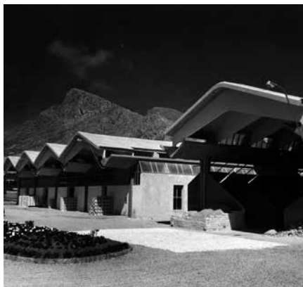
Fig. 2 - Fabbrica Cedis, Palermo, 1954-57. Vista generale del complesso industriale.
