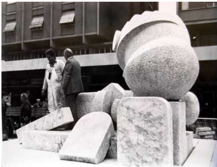
Figura 23. Lavori di messa in opera del Monumento al partigiano di Pietro Cascella (1982), fotografia, Fototeca Storica della Biblioteca Civica Stefano Giampaoli, Massa
