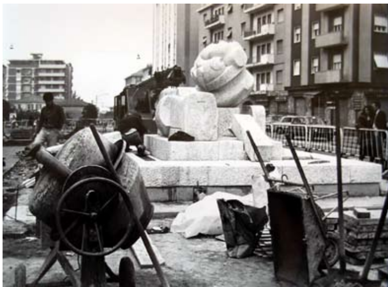
Figura 22. Lavori di messa in opera del Monumento al partigiano di Pietro Cascella (1982), fotografia, Fototeca Storica della Biblioteca Civica Stefano Giampaoli, Massa
