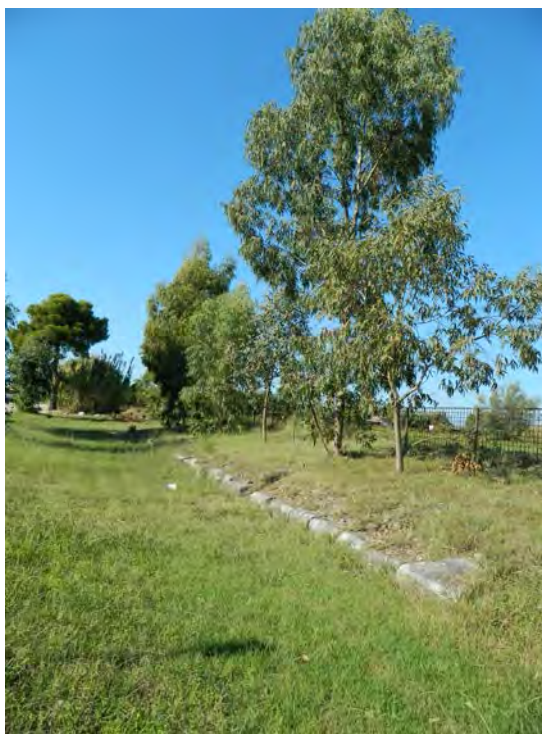
Fig.13.8 - Particolare del marciapiede della via Appia presso Baia Azzurra Fonte: foto di Renata Valente, 2014
