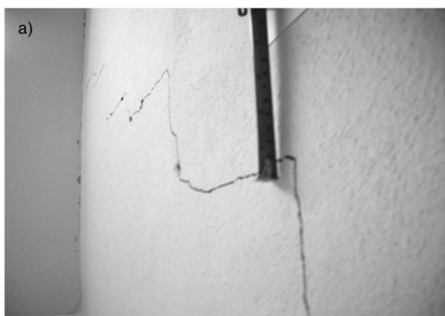
Fig. 18. Details of some cracks detected in the “Sorelle Luppi” school building. Dettagli di fessure osservate nella scuola «Sorelle Luppi»
