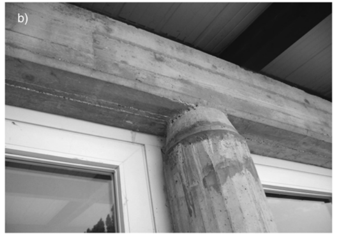
Fig. 26. The nursery of the “Margherita” school building block (a) and a view of the beam-to-column joint (b). L’asilo dell’edificio scolastico «Margherita» (a) e una vista di un giunto trave-colonna (b).
