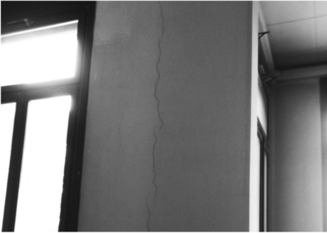
Fig. 20. Vertical cracks in masonry piers of the primary school “Battisti”. Fessure verticali in maschi murari della scuola elementare «Battisti».
