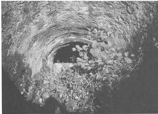
Fig. 6 - Mulino ad acqua, torre di caduta - Comune di Ottati (Sa)
