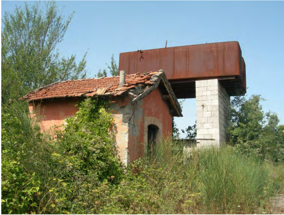
3. Casello e serbatoio d'acqua dismessi nella stazione di Polla (Salerno).
