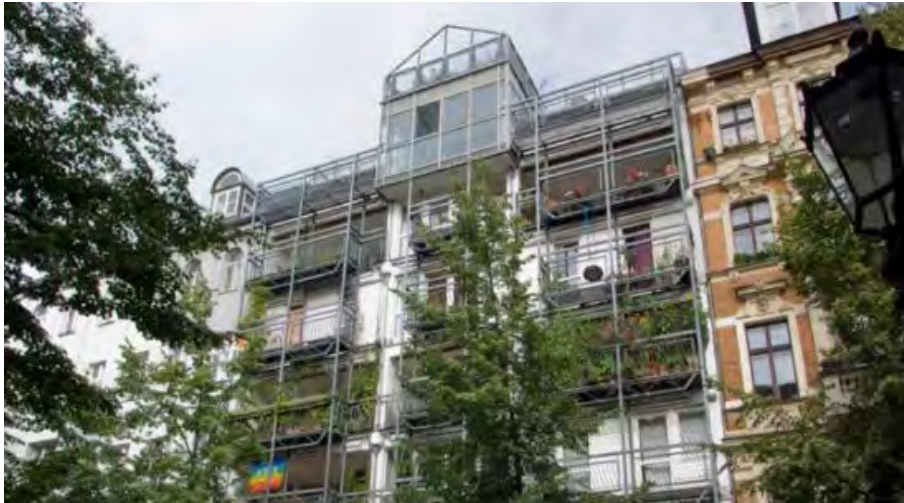
3. Wohnregal Admiralstraße, Zustand Juli 2012 (Foto: Gunnar Klack)
