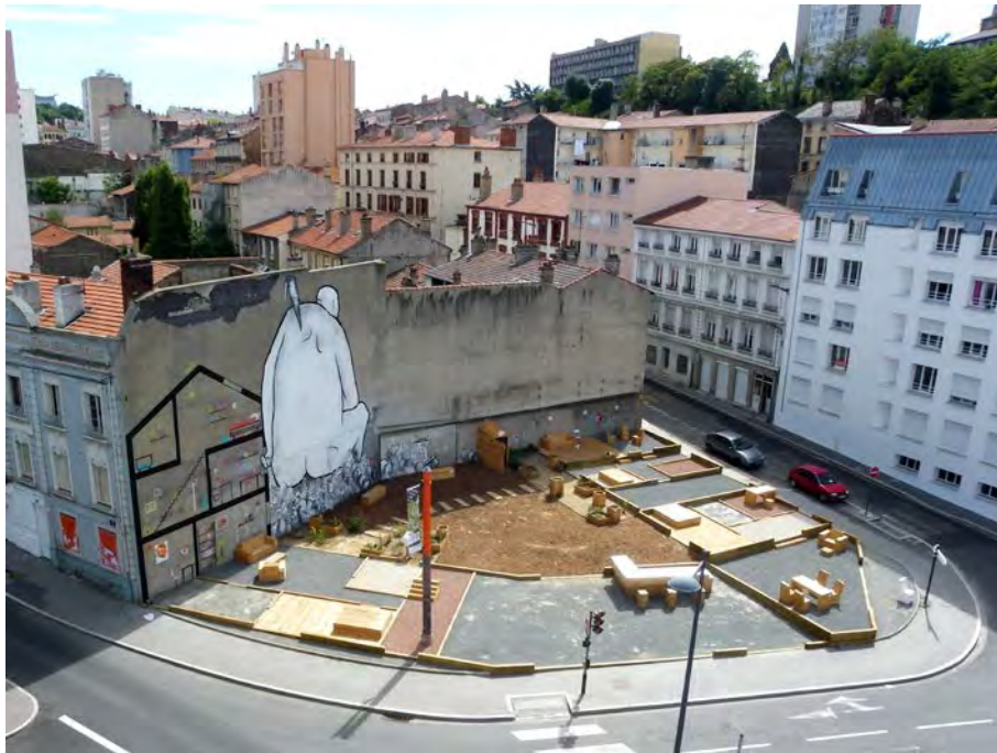
3. Vista generale di Place au changement. Saint Etienne.
