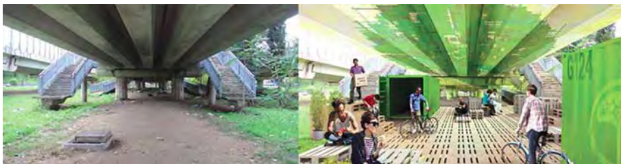
7. Prima e dopo la riqualificazione del Viadotto dei Presidenti, Roma
