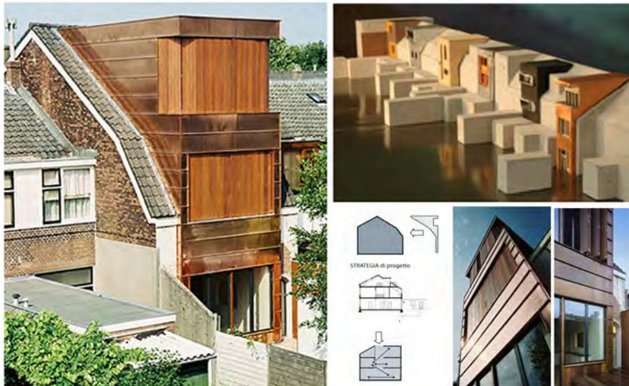
3. Addizione in rame in una residenza del quartiere Wittevrouwen, Utrecht (Paesi Bassi). Progettisti: ZECC ARCHITECTEN (2004 progetto, 2005 realizzazione)
