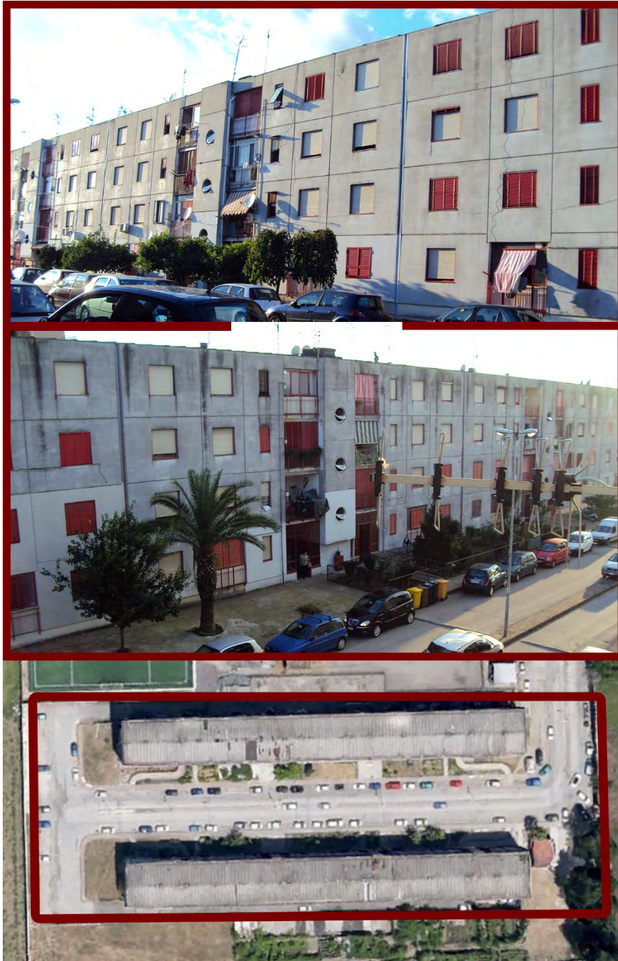
1. Le Palazzine di Casacelle - Prefabbricati pesanti.
