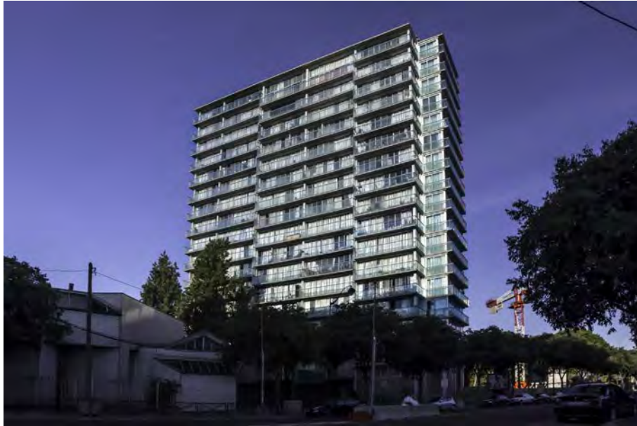
2. La Tour Bois-le-Prete a Parigi, il cui intervento di trasformazione, attuato da Frédéric Druot, Anne Lacaton e Jean-Philippe Vassal ha previsto l'addizione volumetrica esterna di moduli prefabbricati trasparenti. (foto di Matteo Busa)
