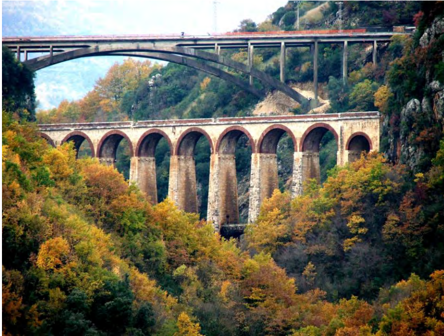
1. Viadotto in disuso lungo l'antica ferrovia Sicignano-Lagonegro
