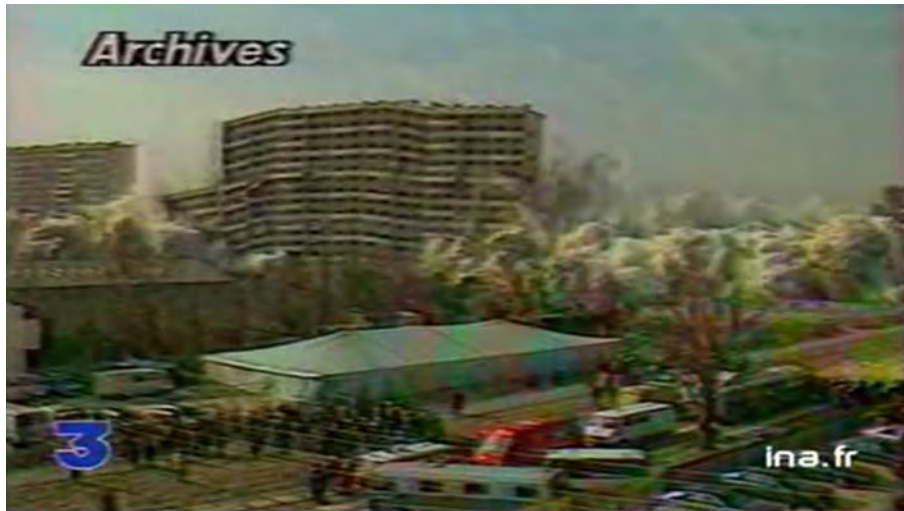
1. Demolizione nel 1983 della Tour Debussy nella Cité des 4000 a La Courneuve
