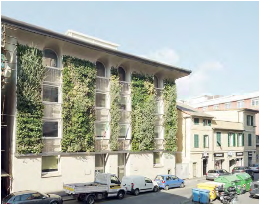
Fig.1 La facciata verde sull'edificio per uffici INPS
