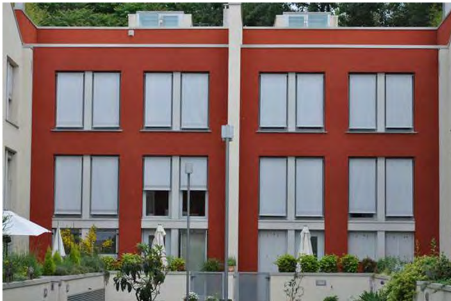
7. vista del particolare di facciata viste degli esterni, degli interni e degli spazi comuni
