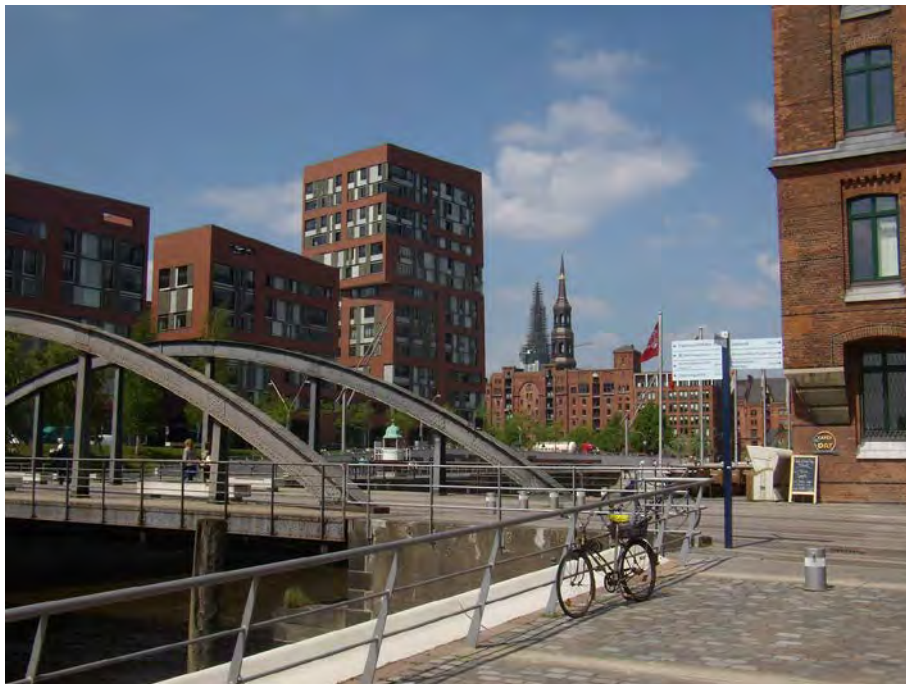
1. Hamburg, Hafencity - La sostenibilità nella zona portuale in cui sono in corso azioni di deep retrofitting è perseguita anche tramite l'eliminazione dei veicoli a motore (foto Frate 2015)
