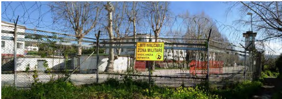
1. Il filo spinato a protezione dell'area è ancora leggibile così come lo è il cartello intimidatorio che sottolinea la presenza di una vigilanza armata a controllo della sicurezza dell'area e del suo limite invalicabile.
