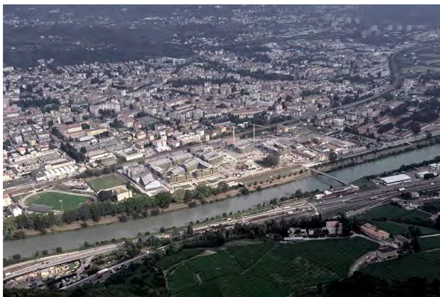
5. Vista aerea del cantiere delle Albere
