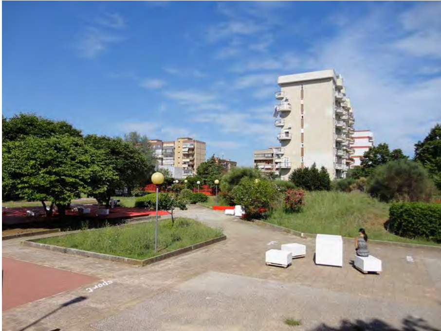
1. Vista generale dell'intervento
