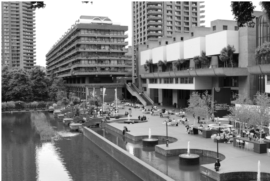
4. Il Barbican Centre, corte interna pubblica che connette il centro agli edifici residenziali
