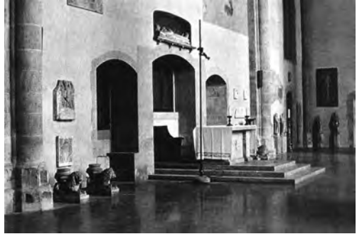
Fig. 13. Napoli, chiesa di S. Chiara, veduta del muro presbiteriale dall'interno del coro delle monache, stato attuale.
