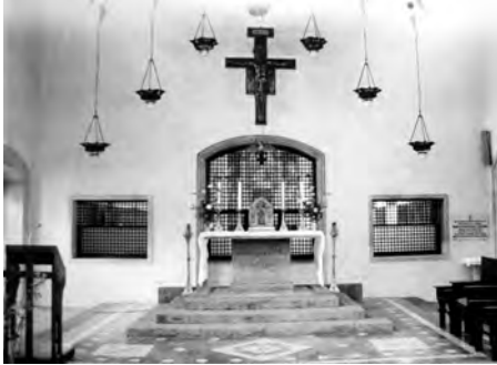
Fig. 12. Napoli, chiesa di Cristo Redentore e S. Ludovico d'Angiò (già refettorio dei frati minori), veduta della parete divisoria da sud, prima dei restauri del 2007 (da Leggenda di S. Chiara Vergine ).
