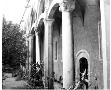
Fig. 6. Napoli, originario convento dei frati minori di S. Chiara, chiostro, particolare della porta di accesso (orientale) all'antico corridoio di separazione tra il refettorio e il capitolo.
