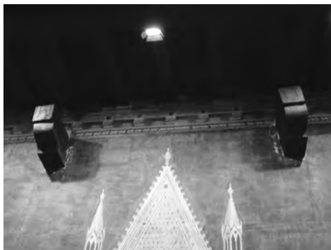
Fig. 10. Napoli, chiesa di Cristo Redentore e S. Ludovico d'Angiò, oratorio delle clarisse (già sala capitolare dei frati minori), parete meridionale, stato attuale del tetto con le antiche ammorsature delle travi lasciate a vista.
