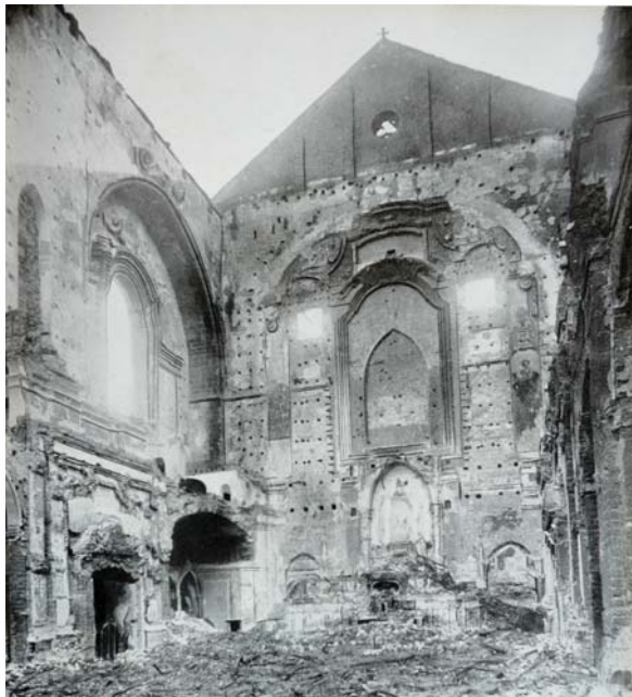
IIIa. Napoli, S. Chiara, veduta del presbiterio dopo il bombardamento del 1943.
