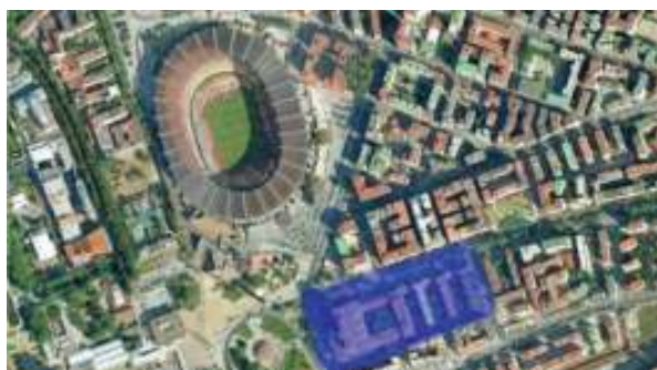
La sede di piazzale Tecchio della Facoltà di Ingegneria. Dall'alto: prospetto; schemi di una iniziale soluzione progettuale; immagine satellitare con individuazione del lotto progettato da Luigi Cosenza.
