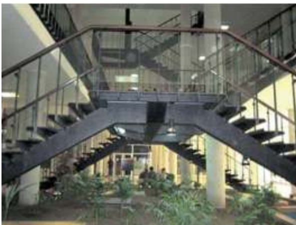
98 Corpo scale di collegamento tra atrio e primo livello.
