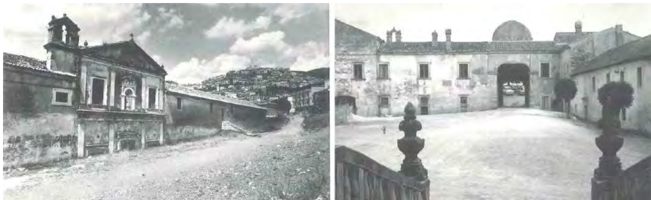
3: Fotografie del muro di cinta e della corte esterna del monastero di Padula nell'Ottocento. Allontanati definitivamente i monaci certosini dalla propria Casa, anche l'azione feudale di controllo sul territorio venne meno, facendo emergere nuovamente il problema dello straripamento del torrente Fabbriato, un piccolo affluente del fiume Tanagro che corre parallelo all'ingresso della Certosa.
